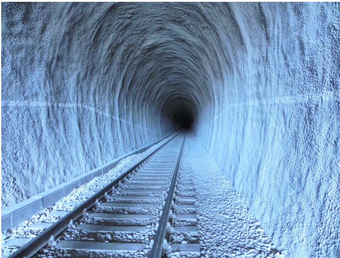
Slika 7-8 Fotografija unutrašnjosti železničkog tunela Budoš, dužine 1.26 km
