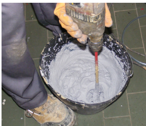
Slika 5.27 - Pripremanje lepka
