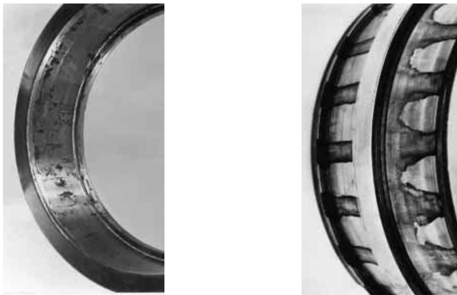
Slika 3.28 – Dubinska korozija ležaja [4]
