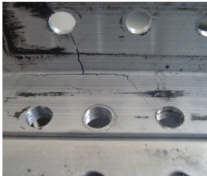
Slika 7.13 Izgled putanje prsline na vertikalnom zidu desnog pojasa ramenjače
