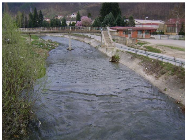
Слика 6.11 Регулисано корито Расине у Брусу
