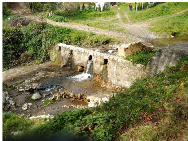
Слика 6.4 Брана и праг у кориту Поповачке реке
