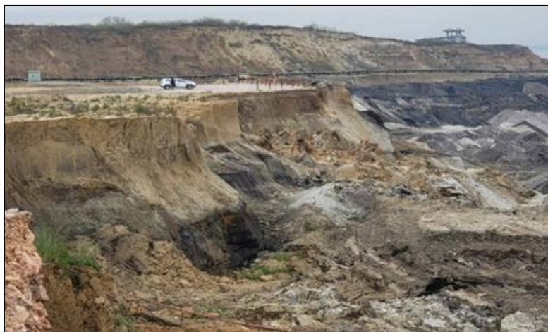
Slika 5.2.1. Rezultat narušene stabilnosti kosine na površinskom kopa Polje E [150]
