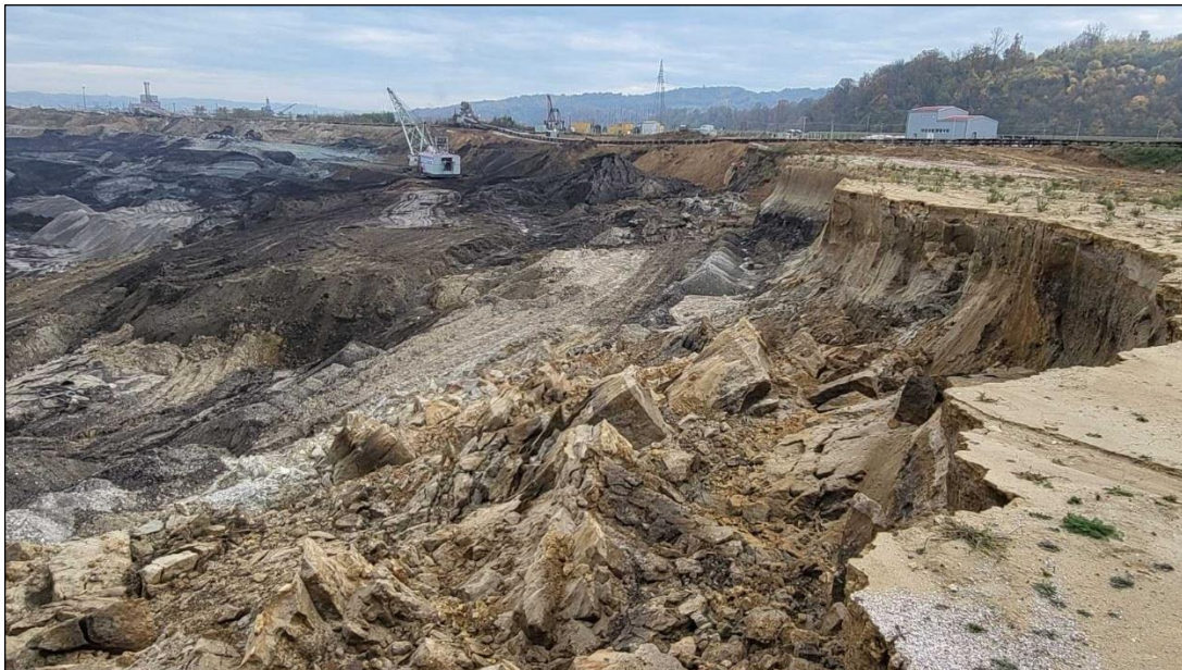
Slika 4.3. Klizište na površinskom kopu Polje E (2024. godina)
