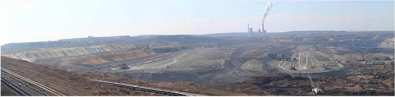
Слика 3.3.24 Унутрашње вишеетажно одлагалиште површинског копа Дрмно [43]
