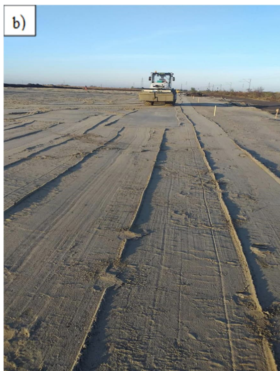
Slika 4.8. a) Šematski prikaz kolovozne konstrukcije sa podlogom; b) Pripreme sloja nasipa na probnoj deonici pristupne saobraćajnice (Intermodalni terminal "Batajnica", 2020)
