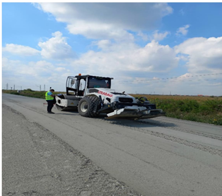
Slika 1.1. Proces zbijanja tokom izgradnje posteljičnog sloja na lokaciji Petlje Batajnica -Autoput E75 u Beogradu (2020)
