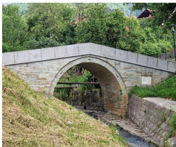
Слика 24. Бели мост у Врању Извор: Марић Станковић, мај, 2023.
