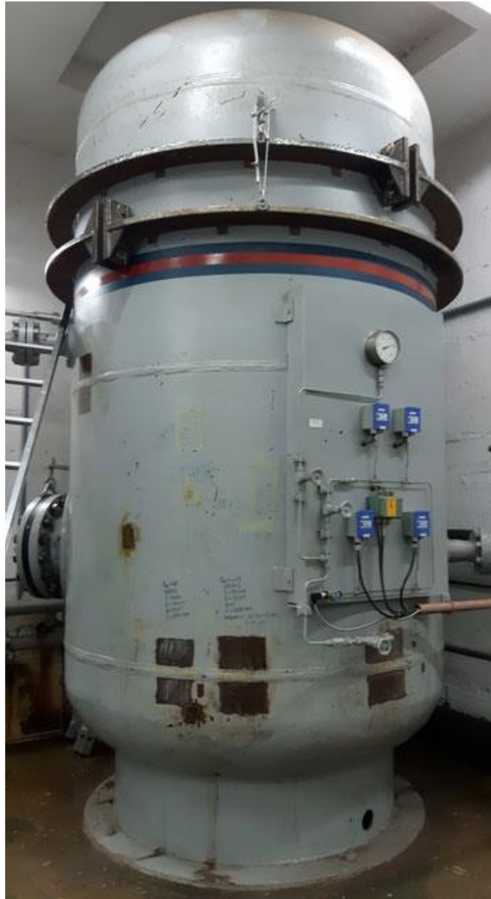
Slika 5. Posuda pod pritiskom nakon postavljanja ukrutnog prsten
