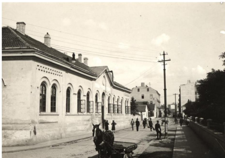
Илустрација 77 - Зграда Главне полиције, 1932. извор: Ulica Braće Jugovića, MGB Ur 11394, http://www.mgb.org.rs/zbirke/istorija-kulture-i-umetnosti/arhitektura-urbanizam/1567-ulica-brace-jugovica (13.08.2021)
