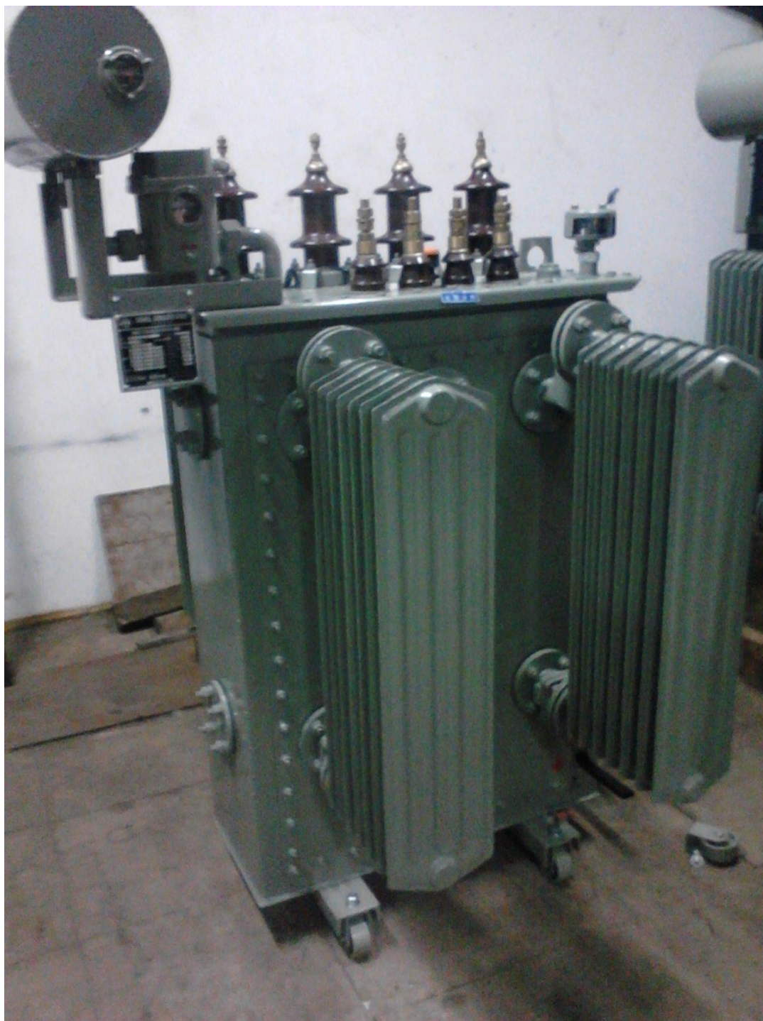
Сл. 5.6 – Експериментални енергетски уљни трансформатори постављени у Термоелектрани „Никола Тесла Б“
