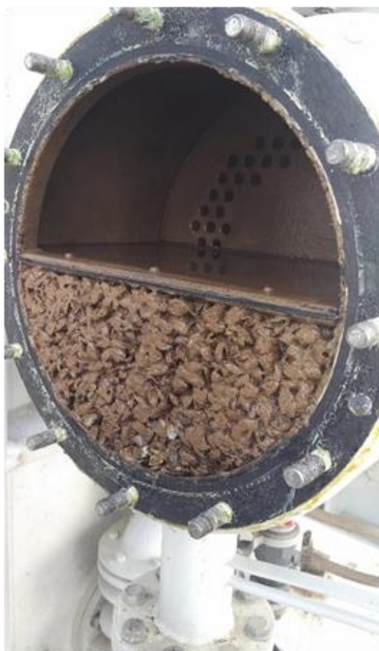
Сл. 9.18 – Колонија зebra шкољки у размењивачу топлоте
