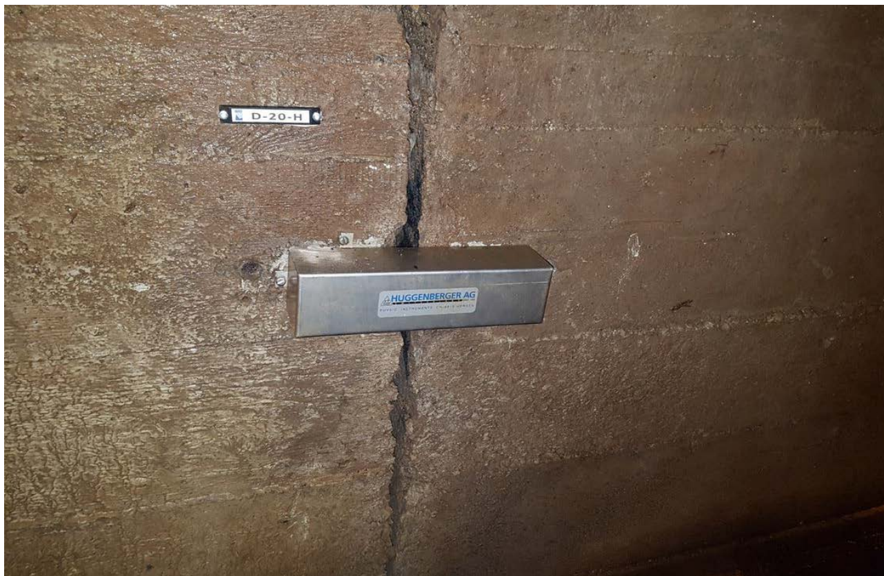
Слика 72. Дилатометар на мерном месту D-20-H [165]
