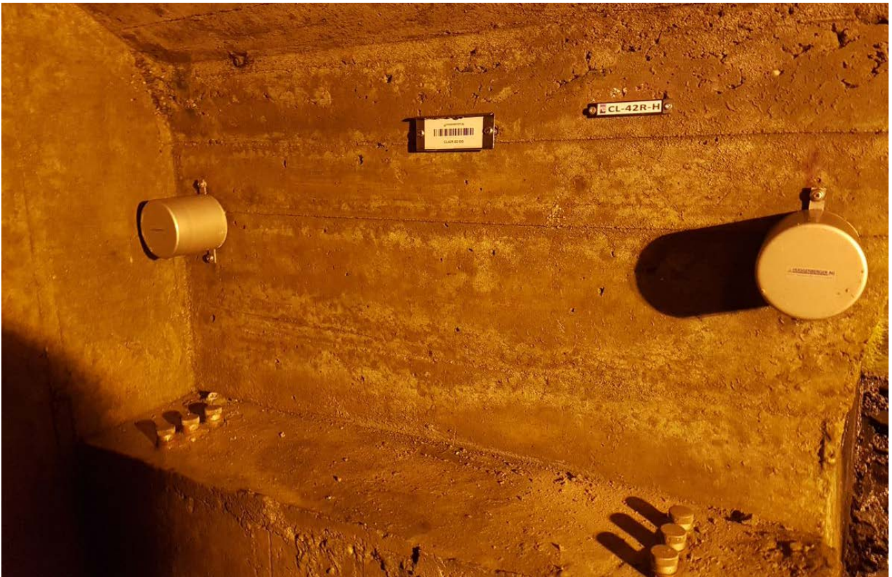
Слика 73. Клинометар на мерном месту CL-42R-H [165]
