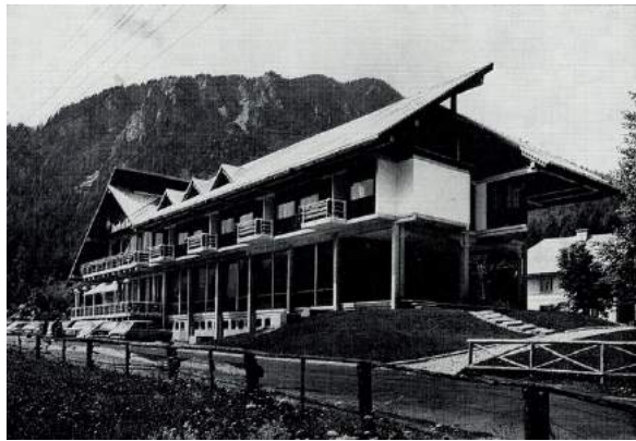
Сл. 488. Иво Пашкулин, хотел Lek у Крањској Гори, 1972. Поглед на предњу фасаду хотела. Извор: Џојек и простор , Br. 237 (1972), 7.
