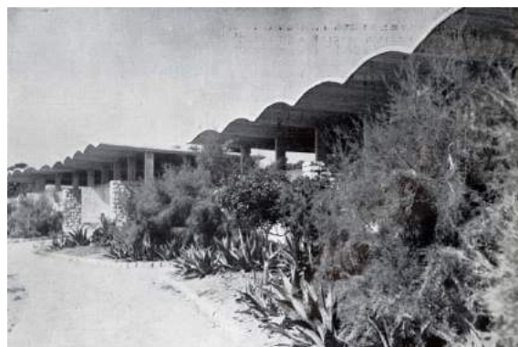
Сл. 233. и Сл. 234. Звонимир Пожгај, градско купалиште у Задру, 1947-1950. Макета купалишта. (лево) Кабине за пресвлачење наткривене заталасаним бетонским љускама. (десно) Извор: Архитектура , Br. 3 (1952), 24.
