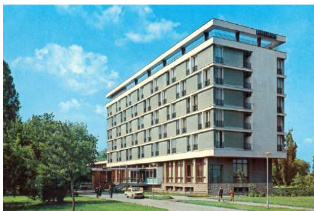
Сл. 310. Сибин и Милена Ђорђевић, хотел Park у Новом Саду, 1962. Поглед на главну фасаду и улаз у хотел. Извор: колекција аутора
