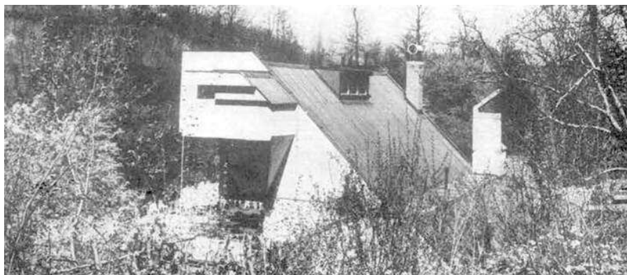
Сл. 475. Михајло Митровић, мотел Mlinarev san на реци Рзав код Ариља, 1975. Поглед на мотел и окружење. Извор: Arhitektura urbanizam , Бр. 82 (1979), 29.
