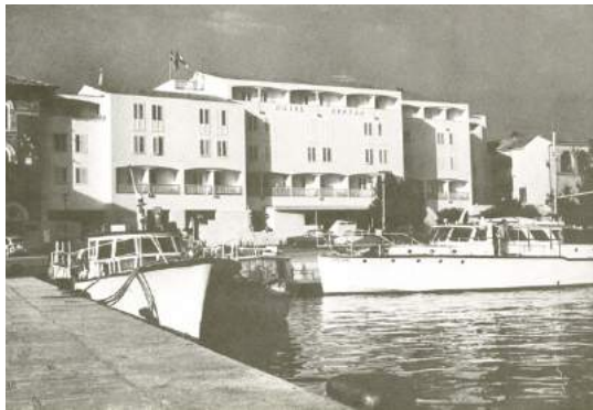
Сл. 409. Јулије Де Лука, хотел Neptun у Поречу, 1968. Поглед на предњу фасаду хотела. Извор: Arhitektura , Бр. 184-185 (1983), 108.
