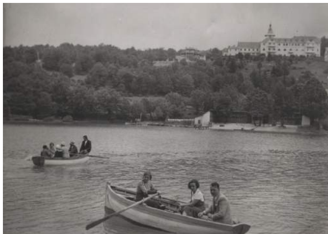
Сл. 154. Поглед са језера Козјак на стари хотел Plitvice изграђен према пројекту чешког архитекте Јосипа Драјка, 1894-1896. Извор: НБ-ПФ [Ф 1790-5]
