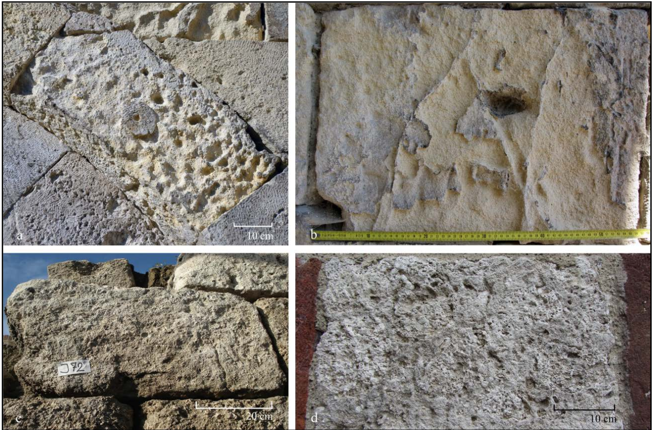
Sl. 55. Reljefno raspadanje krečnjaka Mračne kapije: a) alveolizacija bloka grainstone u unutrašnjem luku II fasade; b) diferencijalno raspadanje kod grainstone sa istaknutim otpornijim žicama i ostacima crne kore u zoni profilisanog portala istočnog dela II fasade; c) zaobljavanje ivica i uglova algalnog rudstone u završnom vencu zapadnog dela II fasade; d) ispiranje komponenti algalnog rudstone na istočnom delu SZ fasade
