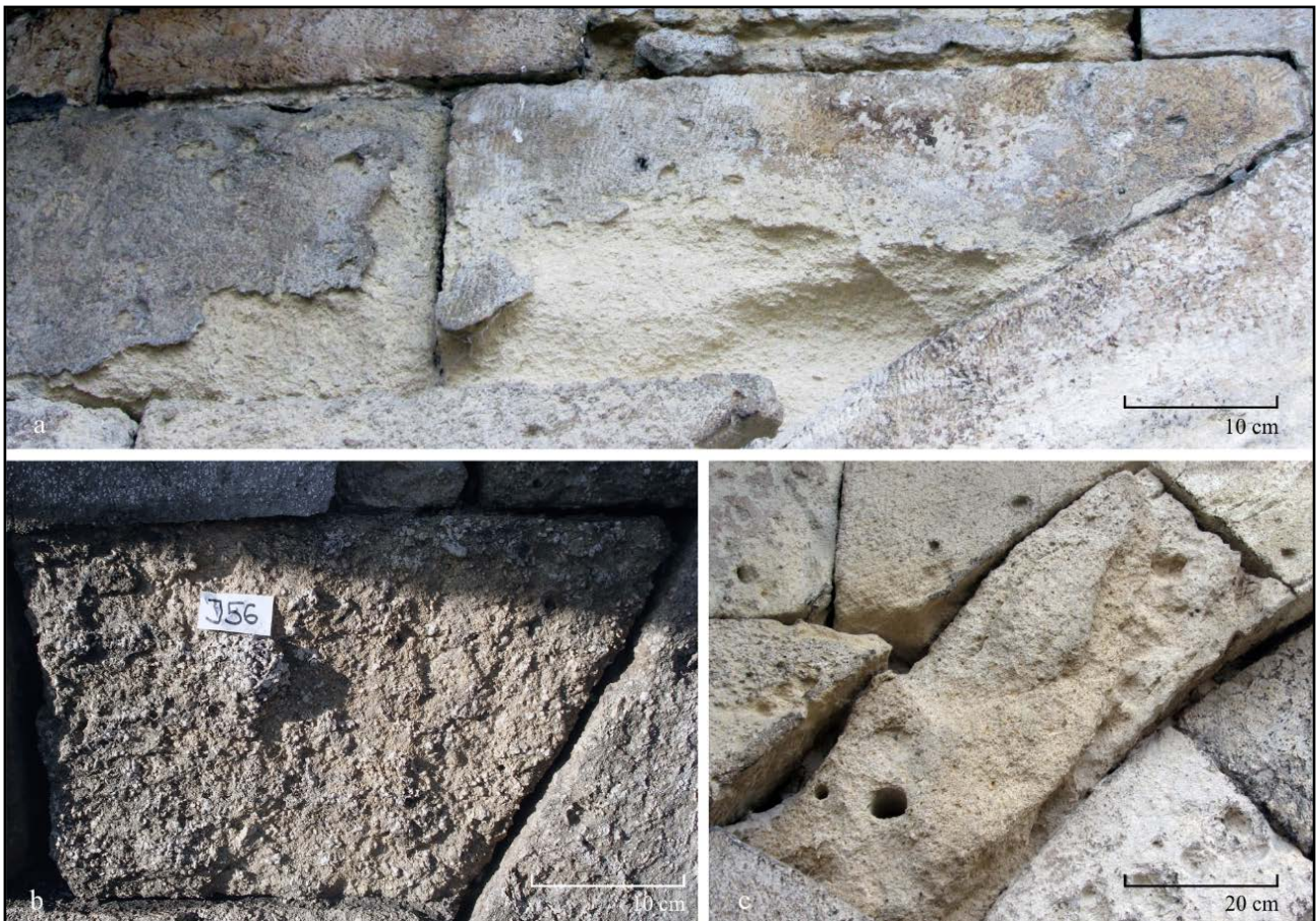
Sl. 54. Dubinsko raspadanje krečnjaka Mračne kapije: a) blokovi grainstone iznad unutrašnjeg luka JI fasade zahvaćeni intenzivnim dubinskim raspadanjem i sa ostacima površinske kore/ljuske; b) algalni rudstone u gornjoj zoni zapadnog dela JI fasade; c) dubinsko raspadanje peskovitog rudstone u unutrašnjem luku zapadne strane JI fasade sa ovalnim šupljinama antropogenog porekla
