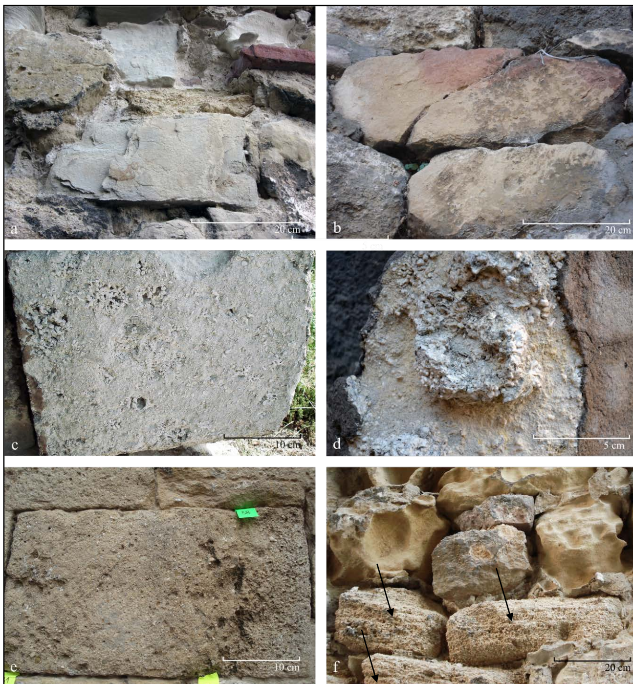
Sl. 42. Izgled krečnjaka ugrađenih u fasade kapija Beogradske tvrđave: a) blokovi grainstone - fasada Zindan kapije; b) oker-ružičasti grainstone severne fasade Kralj kapije; c) algalni rudstone – blok južne fasade kapije Karla VI sa uočljivom algalnom makrofaunom cm-dimenzija; d) algalni rudstone – blok II fasade Mračne kapije; e) peskoviti rudstone SZ fasade Mračne kapije; f) peskoviti rudstone sa klastima terigene komponente i izraženom tankom slojevitošću u fasadi Zindan kapije (blokovi istaknuti strelicama)
