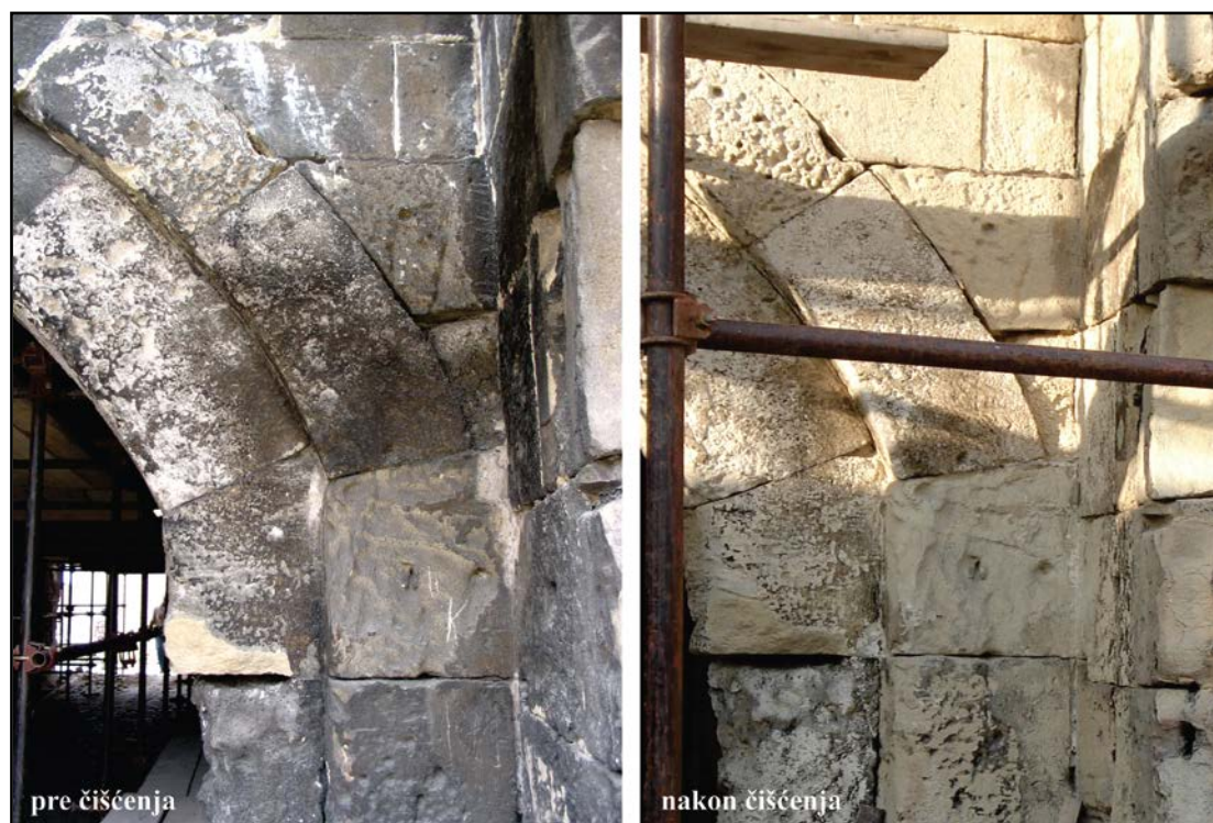
Sl. 8. Izgled dela II fasade pre i nakon čišćenja 2008. godine (Arhiva ZZSKGB)
