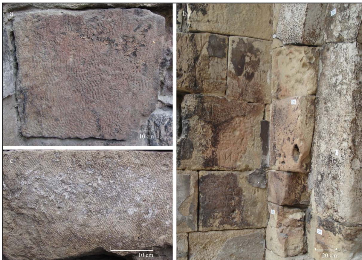
Sl. 59. Forme raspadanja grupe dekolracija/naslage – inkrustacije blokova krečnjaka Mračne kapije: a) obojenje bloka grainstone istočnog dela JI fasade; b) ostaci crnih kora na blokovima grainstone i algalnog rudstone zapadnog dela JI fasade; površine bez kora karakterišu se reljefnim raspadanjem; c) svetle kore na bloku grainstone - istočni deo SZ fasade
