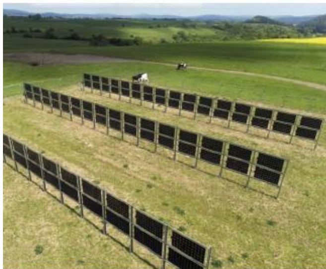
Slika 2.3. FN elektrana sa vertikalno postavljenim FN panelima sa dvostrano aktivnom površinom
