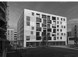
Hunziker Aeral / 2015 Duplex Architekten / Zurich
