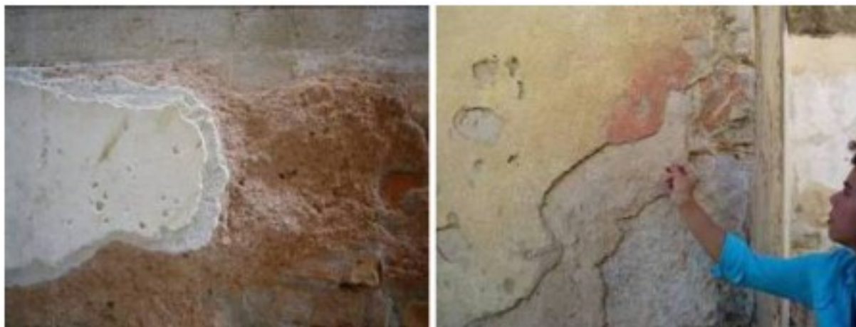
Слика 3.2: Пример слојевитости историјских малтера, преузето из рада [159]
