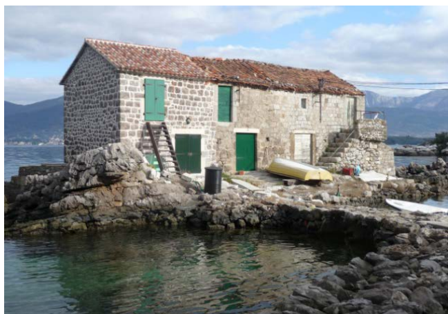
Слика 45 Кућа у Бјелилима, општина Тиват, примјер уклапања вернакуларне архитектуре у природно окружење (Извор: Аутор)
