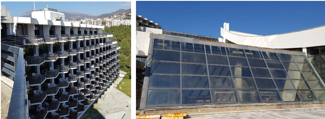
Слика 75 и 76 Медитерански здравствени центар- терасе смјештајног блока (сјенила) и незастакљене стаклене површине јужне оријентације (Извор: Аутор)
