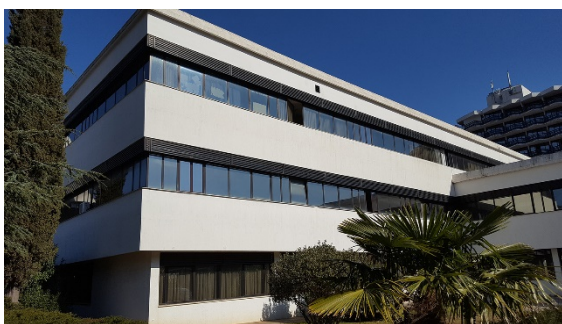
Слика 83 Југо-западна и западна фасада терапијског блока МЗЦ-а (Извор: Аутор)
