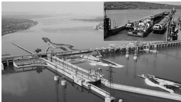
Sl. 6.1 - Prevodnica hidroelektrane Đerdap 2 na Dunavu (zumirana slika u desnom gornjem uglu prikazuje baržu u prevodnici)
