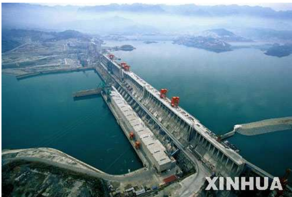
Slika 3: Hidroelektrana „Tri klisure“, NR Kina 27
