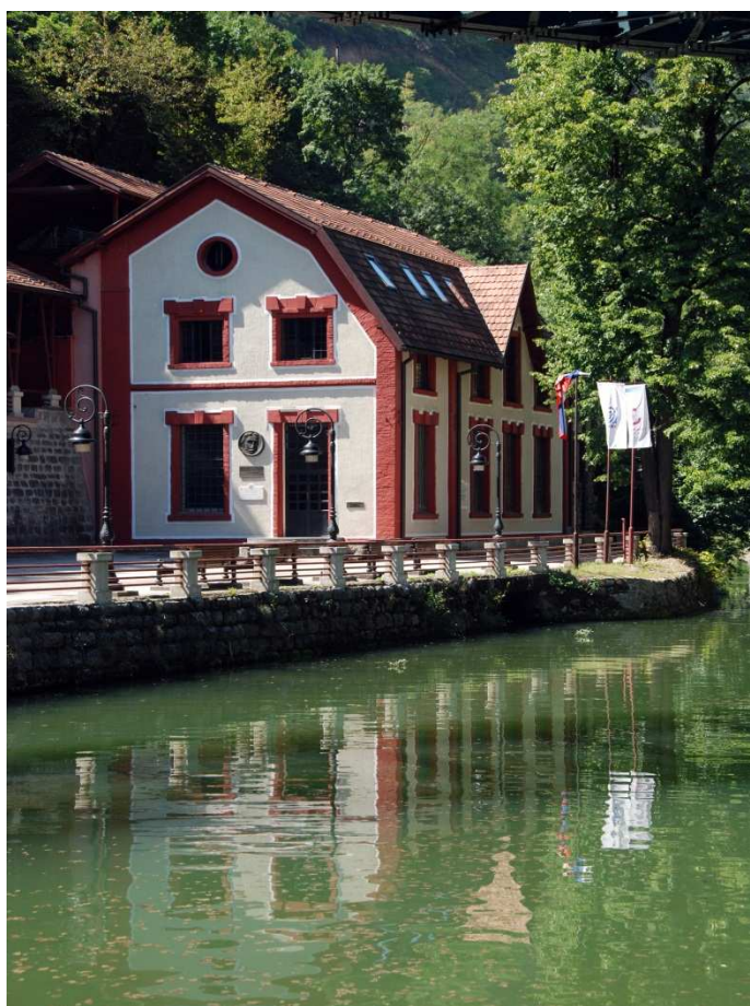
Slika 6: Hidroelektrana „Pod gradom“, Užice 39
