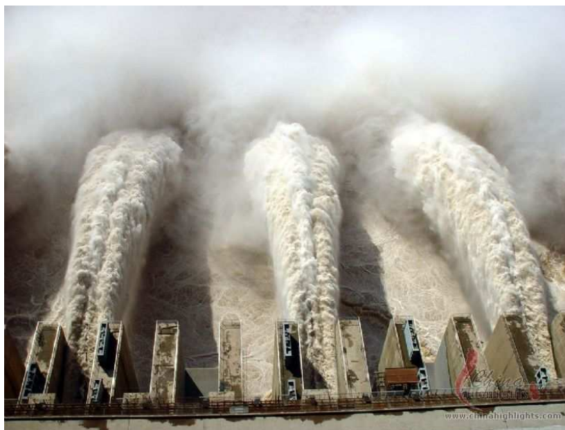
Slika 4: Mlazevi na ispustima hidroelektrane „Tri klisure“, NR Kina 30
