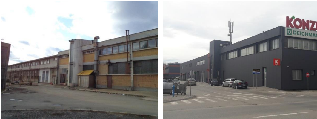
Слика 4.10. Југоисточна фасада зграда галванизације (десно на слици) и монтаже (лево на слици)- пре трансформације (лево) и после трансформације (десно)
