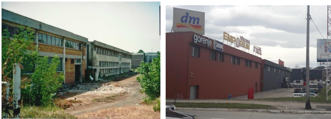
Слика 4.11. Северозападна фасада зграда галванизације (лево на слици) и монтаже (десно на слици)- пре трансформације (лево) (Извор: Пројекат „Урбана регенерација brownfield подручја фабрике „Руди Чајавец“ у Бањој Луци“, 2013. год.) и после трансформације (десно)
