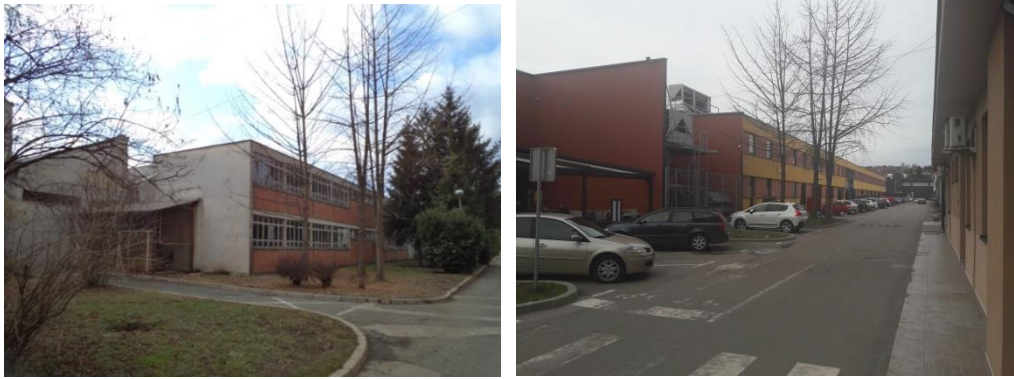
Слика 4.13. Анекс хале „ФЕЛМЕ“ (поглед на са истока)- пре трансформације (лево) и после трансформације (десно)
