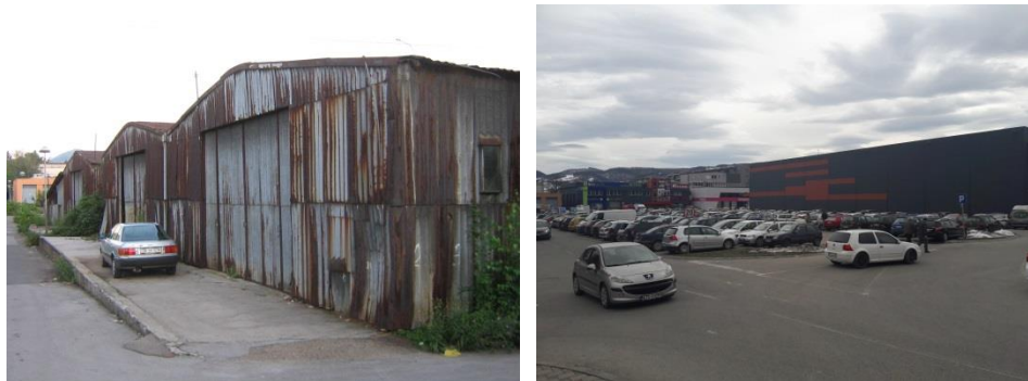
Слика 4.20. Простор уз североисточну фасаду централног складишта- пре трансформације монтажно складиште (лево) и после трансформације паркинг (десно)
