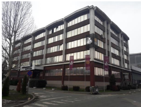
Слика 4.18. Зграда Научно-истраживачког центра
