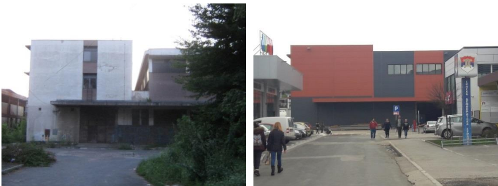
Слика 4.19. Југоисточна фасада зграде централног складишта- пре трансформације (лево) и после трансформације (десно)
