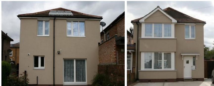
Слика III-9. Пример обновљене куће, дворишна и улична фасада након обнове ( Hounslow Council Passivhaus Retrofit ). Сличност са типом Ц1.3 је евидентна.
