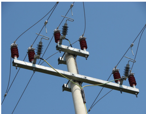
Слика 3.6 – Глава 20 kV стуба са уграђеним линијским одводницима пренапона са екстерним искриштима [107]
