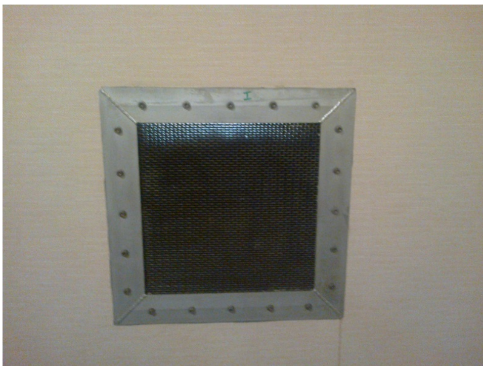
Slika 3.3 Ventilacioni otvor na zidu Faradejevog kaveza
