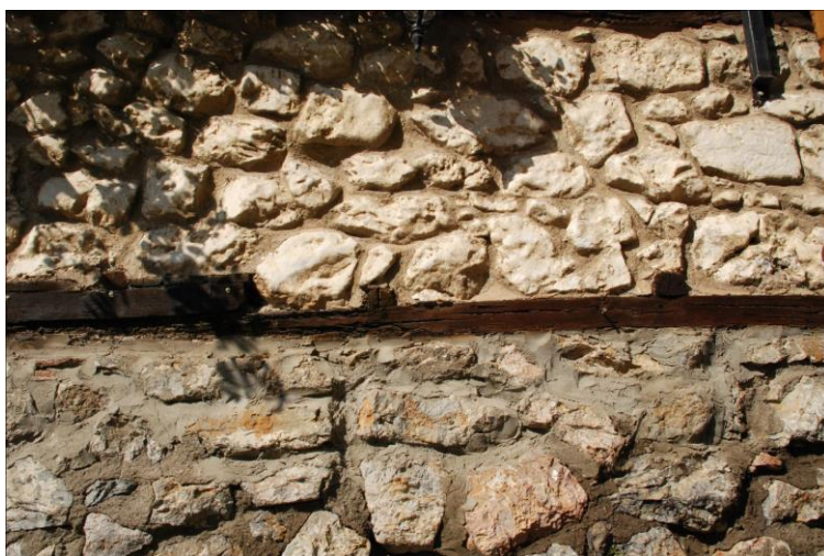
Слика 109. Масивни камени зид грађен у два различита периода од два различита типа камена, Извор: Аутор. Слика 110. Уграђивање надгробног античког постамента у масивни зид једне охридске куће, Извор: фотографска документација из архиве Н.У. ЗЗСКМ – Охрид, (електронски документ).
