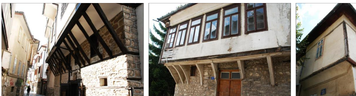
Слика 46. Правоугаони испусти охридских кућа подупрти: видним дрвеним косницима (лево), засебно обраћеним косницима са даскама, трском и малтером (средина) и косницима који су комплетно опшивени даскама, трском и малтером у јединствену форму (десно), Извор: Аутор.
