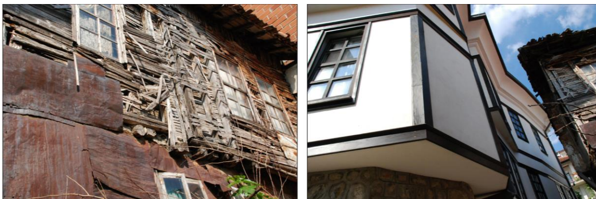
Слика 43. Покушај санације фасаде танким лимом – ламарином (лево), Слика 44. Дрвени опшиви фасаде охридске куће у средишњем делу брда (десно), Извор: Аутор.
