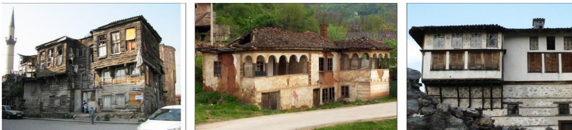
Слика 2. Пример куће која је скоро потпуно изграђена од бондручне конструкције и бондручна фасада није малтерисана са спољашње стране: кућа у Истанбулу (фотографија лево) и примери кућа где су бондручна конструкција и испуна малтерисани: бондручара из Србије (средина) и из Сјатисте, северна Грчка (десно), Извор: Извор: http://www.istanbullite.com/istanbulstories/zevrekmosque-monastery.html http://www.trekearth.com/gallery/Europe/Serbia/North/Serbia/Jelashnica/photo368534.htm https://s-media-cache-ak0.pinimg.com/564x/bc/70/10/bc701039e1a94e21139a808133a824fb.jpg
