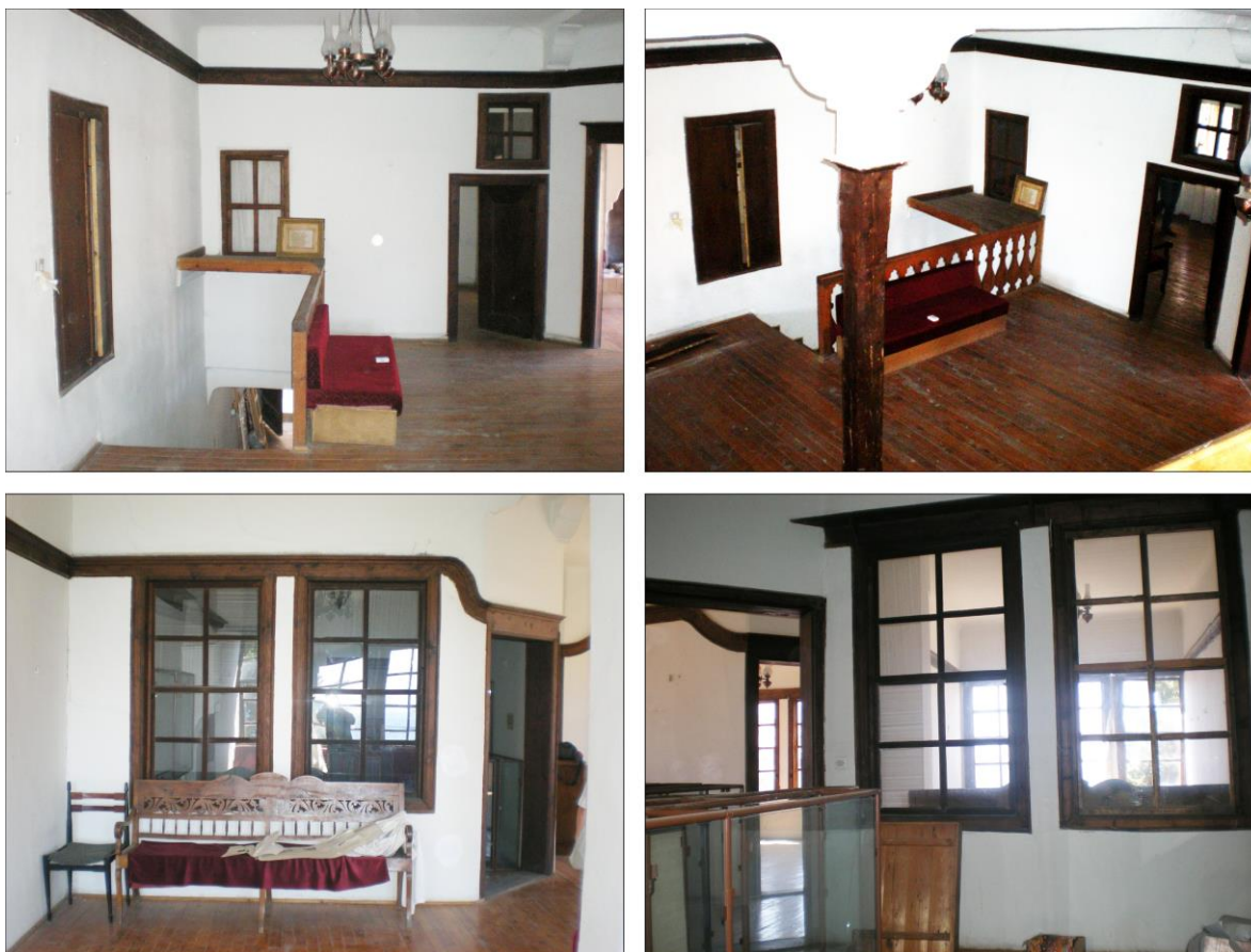
Слика 107. Уграђивање прозора у унутрашњости Куће Уранија како би се повећао светлосни интензитет у неосветљеним просторијама (фотографије из 1998. године – оригинално стање објекта пре изведене ревитализације објекта): Ентеријер на првом спрату – мали унутрашњи прозор изнад врате и један већи изнад ступенице (горње лево и десно); Ентеријер на другом спрату – велики „унутрашњи” прозори на зиду средишње просторије која нема отворе на фасади сликани са обе стране зида (доле лево и десно), Извор: Фотодокументација из архиве НУ ЗЗСКМ–Охрид , Збирка: Фотографска и планска документација за Кука Уранија 1950 – 2010. година, (електронски документ).
