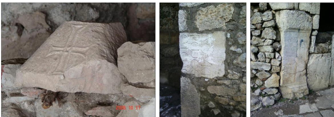
Слика 111. Уграђивање обрађених камених блокова који датирају из периода између 4. и 6. века н.е. у масивном зиду охридских кућа из 18. и 19. века, Извор: фотодокументација из архиве НУ ЗЗСКМ – Охрид.
