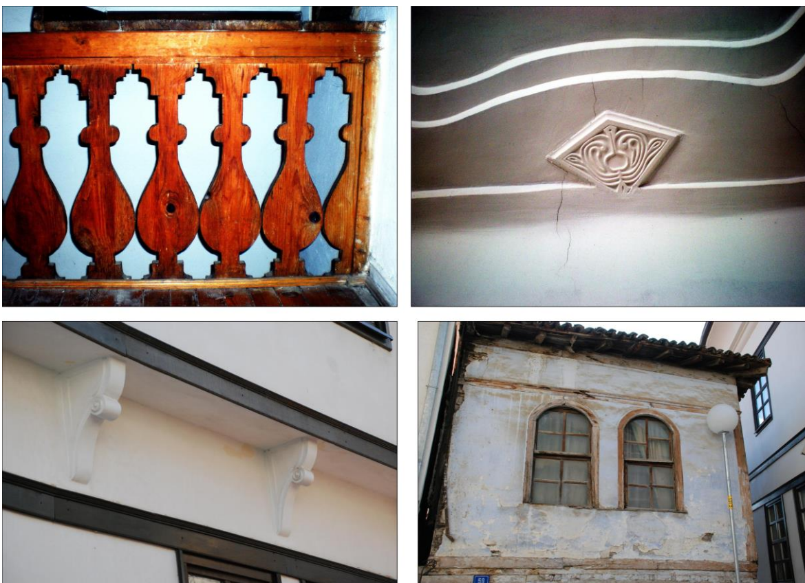
Слика 31. Детаљи са охридских кућа: 1. Дрвена ограда степенишног крака Куће Уранија, 2. Детаљ са малтерисаног тавана у једној просторији куће Уранија, 3. Баркно профилисани косници једне куће у близини цркве Св. Софија, 4. Заобљена форма прозора. Извор: Аутор.
