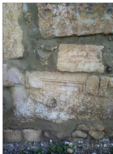
Слика 109. Масивни камени зид грађен у два различита периода од два различита типа камена, Извор: Аутор. Слика 110. Уграђивање надгробног античког постамента у масивни зид једне охридске куће, Извор: фотографска документација из архиве Н.У. ЗЗСКМ – Охрид, (електронски документ).
