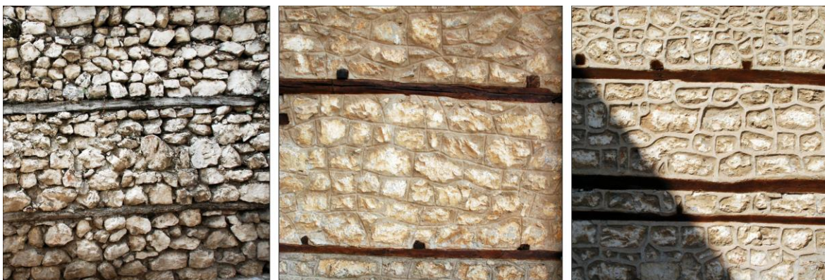
Слика 117. Изглед масивног зида охридске куће: 1. Пре израде декоративних fuga, 2. Након израде удубљених малтерисаних fuga; или 3. Након израде испупчених малтерисаних fuga, Извор: Аутор.
