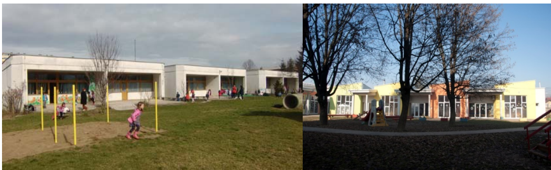
Slika 5.6. Dvorišni izgled vrtića Neven (lijevo) i vrtića Kolibri (desno)
