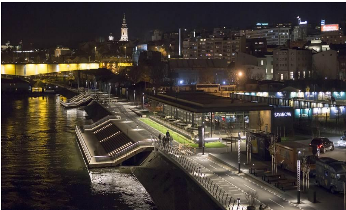
Слика 19 – Изведене инсталације на постојећој обали утврде
