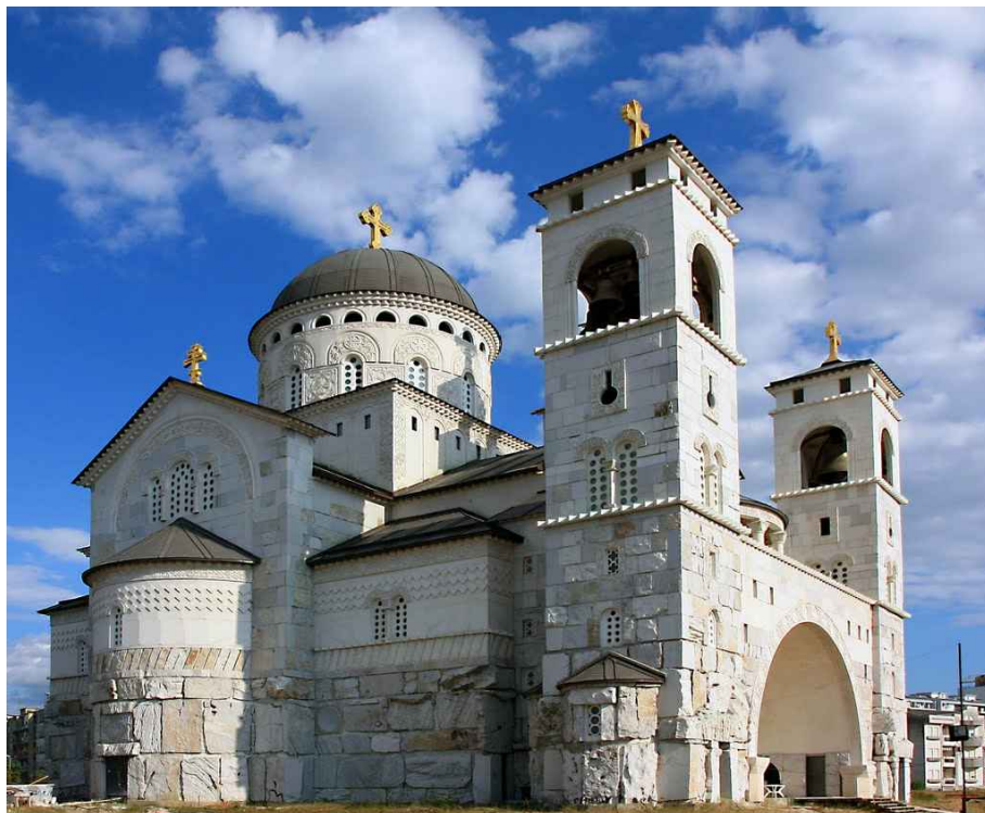
11.7. поглед из правца северозапада извор: http://www.panoramio.com/photo/39387007
