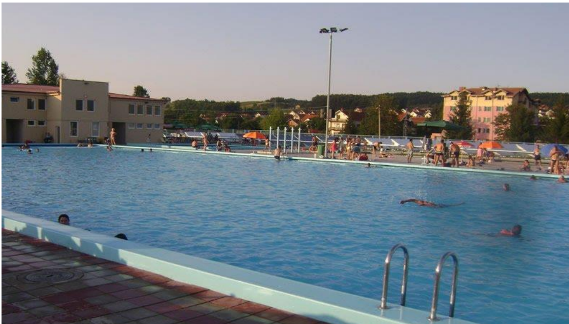
Сл. 5.42. БАБУШНИЦА - ГРАДСКИ БАЗЕН
