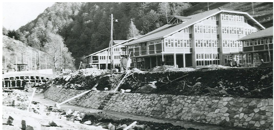
Ст. 11.2. УРЕЂЕЊЕ ВОДОТОКОВА У ЦЕНТРУ НАСЕЉА ИЗГРАЂЕНО ЈЕ ЈОШ 1974. ГОДИНЕ
