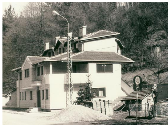
Сл. 7.30. ЗГРАДА ЕЛЕКТРО - ДИСТРИБУЦИЈЕ У ЦРНОЈ ТРАВИ
