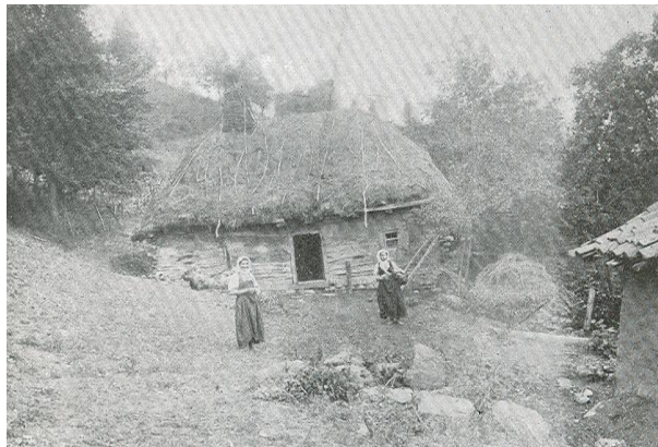
Сл. 8.7. ЈЕДНОДЕЛНА КУЋА ОД ПЛОТА ПОКРИВЕНА СЛАМОМ (ИЗВОР: Николић, Р., 1912.)
