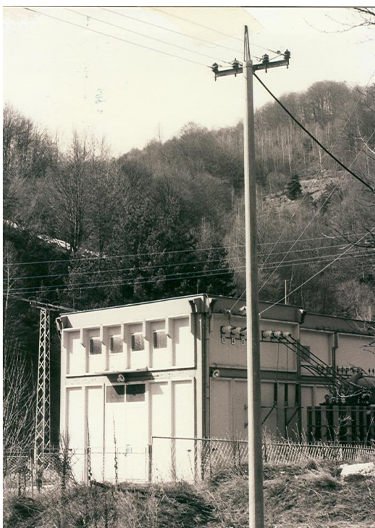
Сл. 7.29. ОБЈЕКАТ ТРАФО - СТАНИЦЕ У ОКВИРУ ЈЕДНОГ ОД ИНДУСТРИЈСКИХ ОБЈЕКАТА
