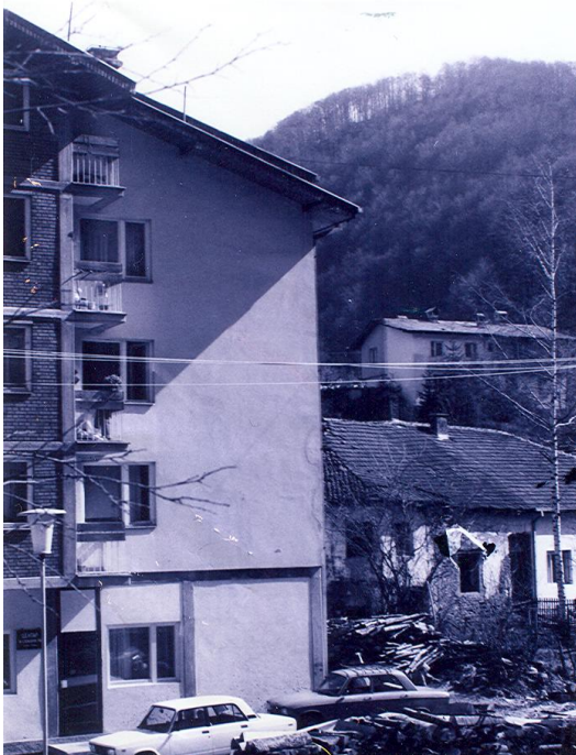
Ст. 7.44. ТРАНСФОРМАЦИЈЕ ЦЕНТРА ЦРНЕ ТРАВЕ (СТАРИ ОБЈЕКАТ САДА НЕ ПОСТОЈИ)
