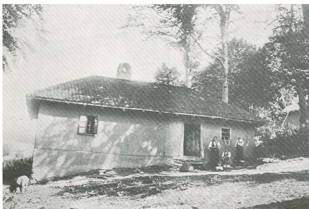
Сл. 8.14. СТАРА ЂЕРАМИДНА КУЋА-БОНДРУЧНА КОНСТРУКЦИЈА (ИЗВОР: Николић, Р., 1912.)
