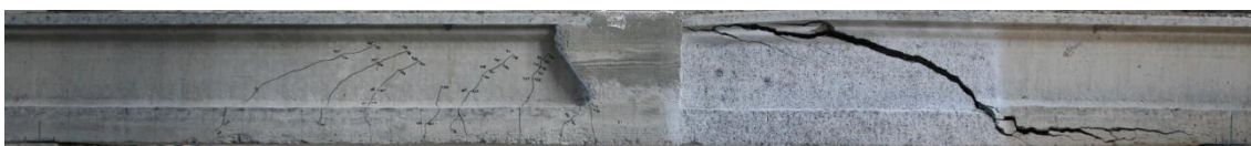
Slika P .5-9: 350-185/80-1: Prikaz prslina nakon loma grede: na južnom (a) i na severnom licu grede (b)
