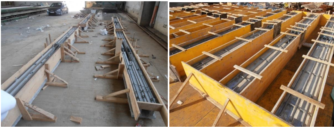
Slika 4-5 Pripremljene grede neposredno pre betoniranja
