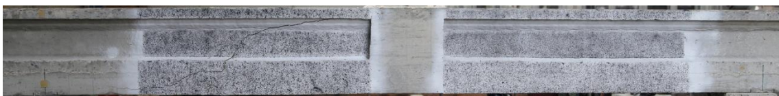
Slika P .10-10: 265-135/135: Prikaz prsline nakon loma grede: na južnom (a) i severnom licu (b)
