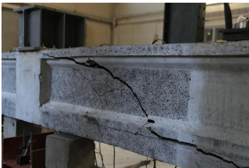
Slika P .9-11: 350-185/35: Prikaz prsline na severnom licu grede nakon loma
