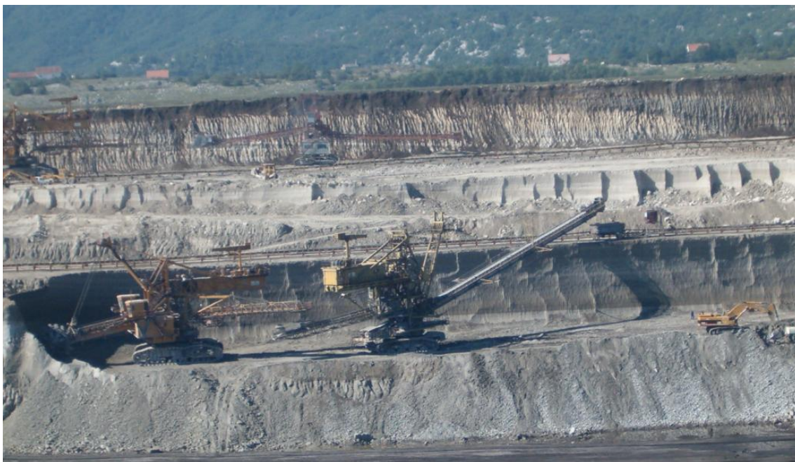
Slika 2.1. Rotorni bager ER-1250 16/1,5 u BTO sistemu
