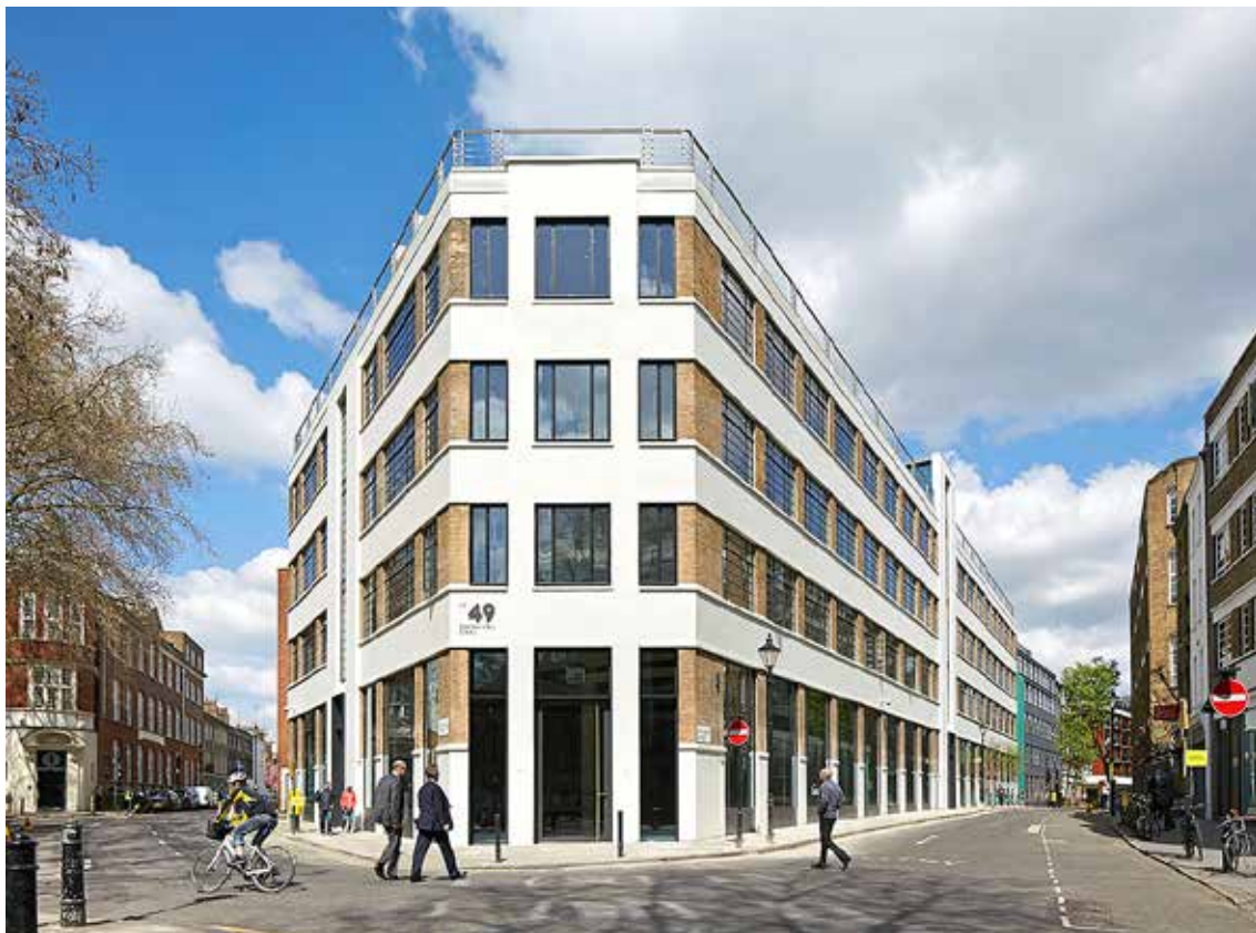
Слика 3.2 Зграда Buckley (Извор: Derwent, 2015)
