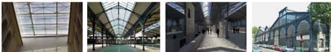
Слика 5.25 Интеграција фотонапонских ћелија у кровне прозоре (Извор: Troi, 2013)
