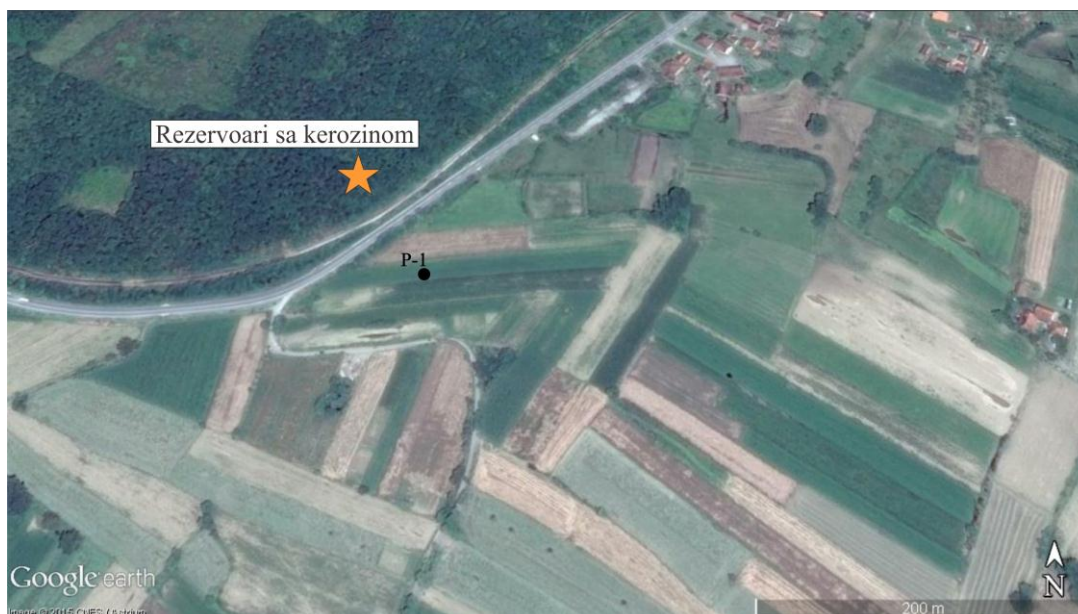
Slika 4.10. Položaj osmatračkog objekta P-1 na lokaciji u Vitanovcu
