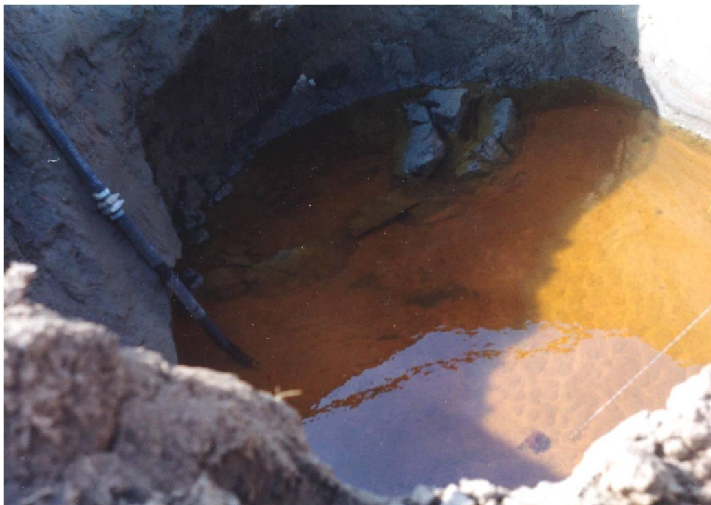
Slika 4.8. Crpenje kerozina iz kopanog bunara (foto: Matić, 1994)
