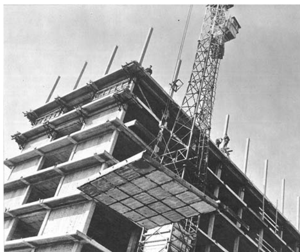
Ил. 5.2.2–2. Префабрикација и унификација: „Монтажа таванице од преднапрегнутог бетона“, Извор: Миливоје Ковачевић, и др., Нови Београд · нови град (Београд: Дирекција за изградњу Новог Београда, 1961), стр. 73.
