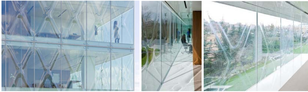
Слика П1.33. Геометрија стаклених панела и оптичка дисторзија посматрана из ентеријера као последица форме панела; (Извор: Преузето са http://www.rex-ny.com/work/vakko-fashion-center/ , 16. 5. 2015)
