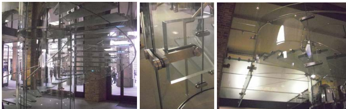
а) Изглед кружног степеништа у продајном простору; б) Детаљ везе стаклене греде за укрућење са централним стубом састављеним од цилиндрично-закривљених панела; и ц) Веза образне греде – стаклене ограде са стакленим подестом; (Извор: Аутор, 2014)
