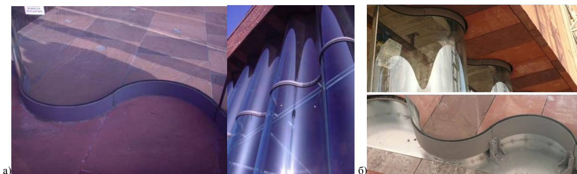
Слика П1.72. а) Изглед U -профила (дужине половине S -форме панела) који прихвата панел по хоризонталним спојевима у доњем делу, средини и врху стакленог омотача висине 11m; б) постављање U -профила (Извор: а) Аутор, 2012; и б) Nijssse, 2013: 29)
