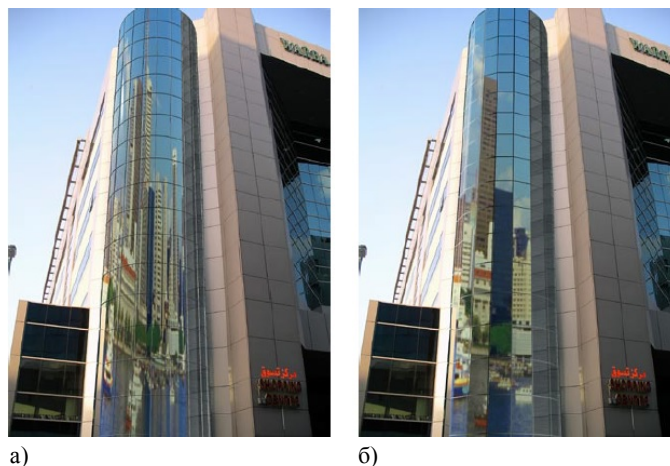
Слика 5.4. Разлика у рефлексији стакленог омотача: а) Са закривљеним стакленим панелима; б) Са равним стакленим панелима; (Извор: Saksala, 2005)
