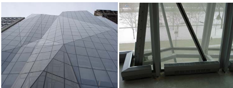
Слика П1.4. Изглед стаклених панела фасаде Спертус института из екстеријера и ентеријера (Извор: Преузето са http://www.flickrriver.com/photos/atelier_flir/sets/72157603513965733/ , 11. 4. 2015)
