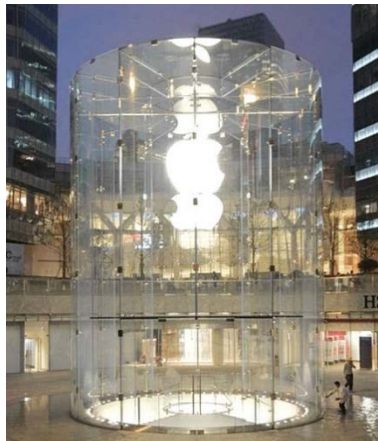
Слика П2.8. Кружна стаклена структура у виду цилиндра пречника 10m, која се састоји од 12 m високих стаклених стубова и конзолних стаклених греда, као и једнострано-закривљених стаклених панела димензија 2,6 x 12 m, формира импресиван улаз у подземни објекат Apple , Пудонг, Шангај; (Извор: Преузето са http://www.eocengineers.com/project/apple-ifc-shanghai-109 , 14. 1. 2016)
