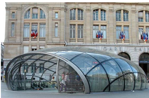
Слика П1.76. Изглед и геометрија надстрешнице улаза у станицу метроа Lentille, St. Lazare , Париз настала комбиновањем сферичних сегмената преко торусне форме, и детаљ везе закривљених стаклених панела и челичне конструкције; (Извор: Baldassini, 2008: 7; и Raynaud, 2014: 58)
