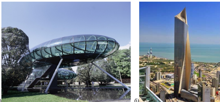
Слика 3.17. Примери термички савијеног стакла примењеног на омотачу архитектонских објеката: а) Nardini Grappa Distillery , Вићенца, Италија, Масимилијано Фуксас (Massimiliano Fuksas), (обликовано уз помоћ калупа); и б) Al Hamra Tower , Кувајт, Скидмор, Овингс и Мерил ( Skidmore, Owings and Merrill ), (обликовано на производној линији) (Извор: Преузето са а) http://www.archdaily.com/233532/nardini-grappa-distillery-bolle-massimiliano-and-doriana-fuksas/maurizio-marcato_nardini_fuksas_003-copy/ , 12. 4. 2014; и б) http://www.archdaily.com/196714/al-hamra-firdous-tower-som/ , 12. 4. 2014)
