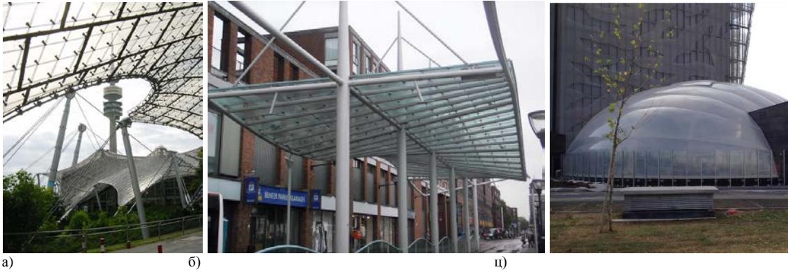
Слика 1.15. Различити начини генерисања површи: а) Обешена и преднапрегнута мембранска конструкција (акрилно стакло) олимпијског парка у Минхену, 1972, архитекте Фрај Ота добитника Прицкерове награде за 2015.год.; б) обешена конструкција коноидне геометрије аутобуске станице Зуидпорт у Делфту; ц) Пнеуматски панели зимске баште Форума у Верони (термопластични флуорокарбонатни полимер-ETFE); (Извор: а) Преузето са http://www.dezeen.com/2015/03/11/frei-otto-a-life-in-projects/ , 24. 6. 2015; б) Аутор, ц) Преузето са http://canobbio.net/spry.php , 24. 6. 2015)
