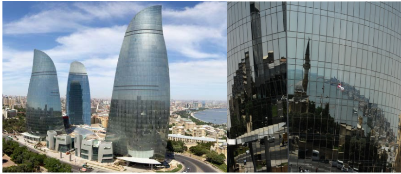
Слика П2.1. Небодери Flame Towers , Азербејџан: а) урбано окружење; б) материјализација закривљене стаклене фасаде помоћу равних стаклених елемената; (Извор: Преузето са а) http://www.archdaily.com/538883/baku-flame-towers-hok ; б) http://azertag.az/en/xeber/Baku_2015_Torch_descends_Flame_Towers_in_spectacular_abseil_VIDEO-862177 ; 18. 1. 2016)
