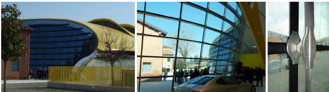
Слика П1.55. Изглед фасаде из екстеријера и ентеријера и детаљ везе-споне за прихватање ТИ панела вертикалним кабловима (Извор: Blandini et al., 2012: 1-3)
