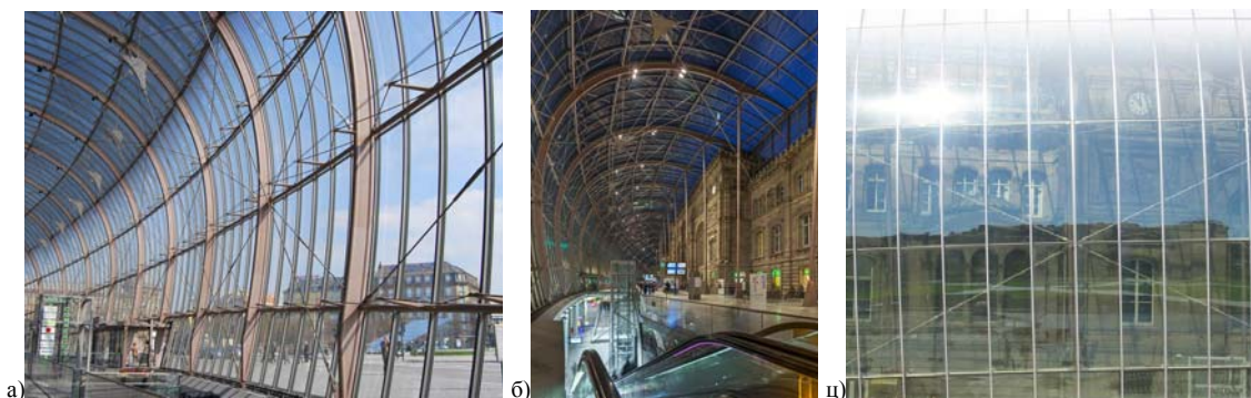
Слика П1.75. Железничка станица Strasbourg TGV : а) Унутрашњи изглед стакленог омотача и челичне конструкције; б) Природна вентилација кроз приступ метро станици; и ц) Спољашњи изглед стакленог омотача; (Извор: Преузето са а) http://blog-bilinguisme.fr/seul/une-minute-difference-france-alle/ ; б) https://en.wikipedia.org/wiki/Gare_de_Strasbourg ; ц) Baldassini, 2008: 10)
