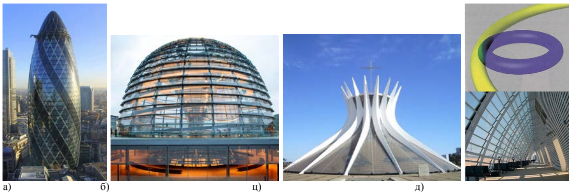
Слика 1.19. Ротационе површи реализоване као челично-стаклене конструкције: а) Троугаоно-ромбоидна мрежа торња Gherkin у Лондону у форми "бачве"; б) Купола Reichstag у Берлину архитекте Нормана Фостера у форми половине ротационог елипсоида; ц) Катедрала у Бразилији архитекте Оскара Нимејера у форми једнограног ротационог хиперболоида; д) Геометријска форма железничке станице TGV у Авињону настала пресеком два прстенаста торуса;
