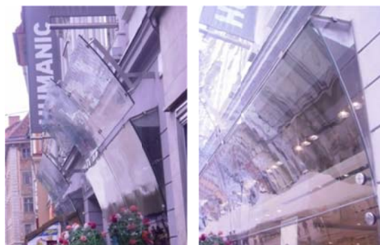
Слика 5.51. Цилиндрично закривљено стакло са видно наглашеном дисторзијом у виду таласа узрокованом процесом термичког каљења на производној линији; (Извор: Аутор, 2014)
