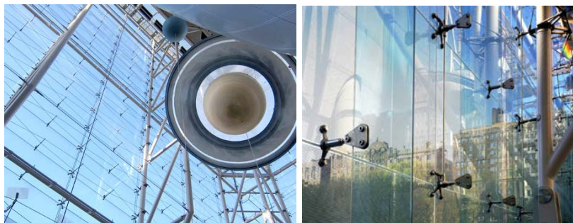
Слика 1.38. Челични елементи израђени уз помоћ прототипа произведеног уз помоћ адитивне фабрикације за Rose Center for Earth and Sciences , Ennead Architects , Њу Јорк, 2000; (Извор: Преузето са: http://www.heintges.com/project.php?id=amnh-rose-center , 17. 2. 2016)
