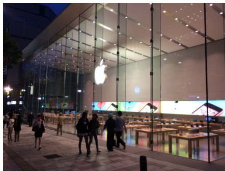
Слика П2.6. Хемијски каљени, троструко ламинирани стаклени панели димензија 3x11m, објекат Apple у Токију;
