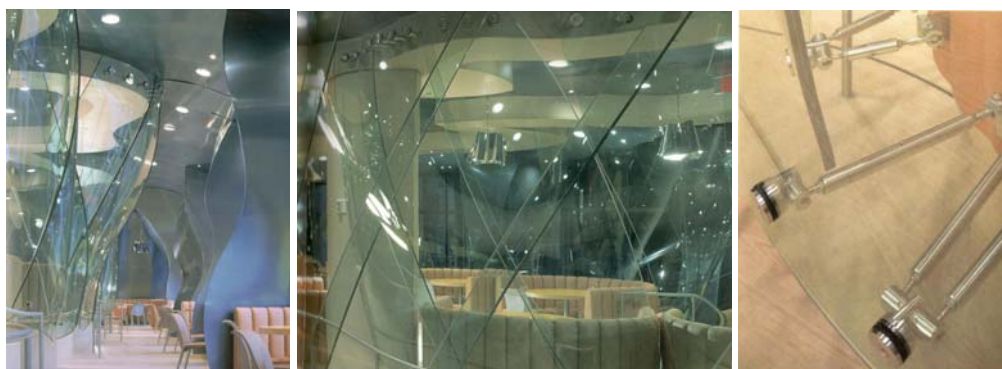
Слика П1.82. Закривљени стаклени панели као елемент који раздваја различите просторе кафе-ресторана и детаљ зглобне везе (гумени дихтунг) са челичним-инокс конектором помоћу кога су ношени стаклени панели; Conde Nast Cafe , Њу Јорк (Извор: Richards, 2006: 144, 145, 149)
