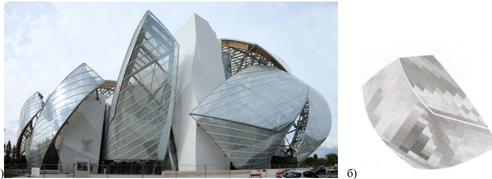
Слика П2.9. Различита закривљеност стаклених панела (3.600 елемената) омотача објекта фондације Луј Витон, Париз: а) Изглед стакленог омотача; б) Одговарајућа панелизација показује континуалну закривљеност сваког цилиндричног панела; (Извор: а) Преузето са Frank Gehry Biography , http://www.achievement.org/autodoc/page/geh0bio-1 , 21. 1. 2016; б) Raynaud, 2014: 60)
