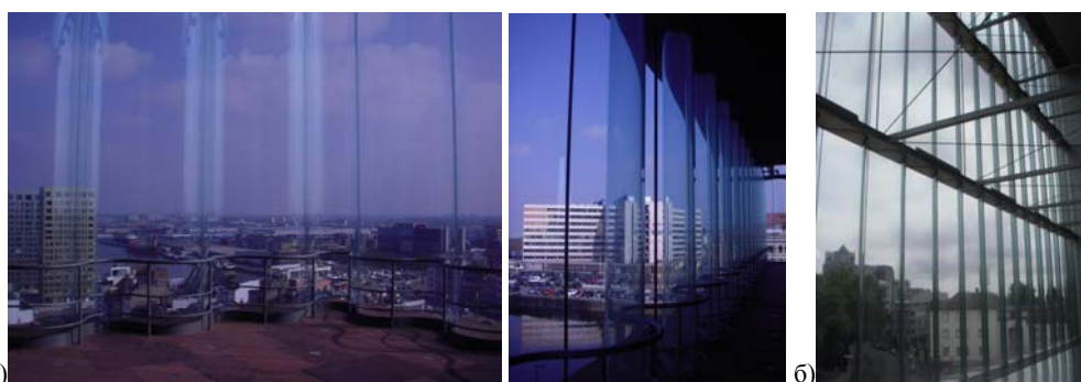
Слика П1.70. Деформације перспективне слике посматране кроз таласасто закривљено стакло: а) МАС музеј, Антверпен; б) Кућа музике ( Casa da Musica ), Порто; (Извор: Аутор, 2012, 2015)
