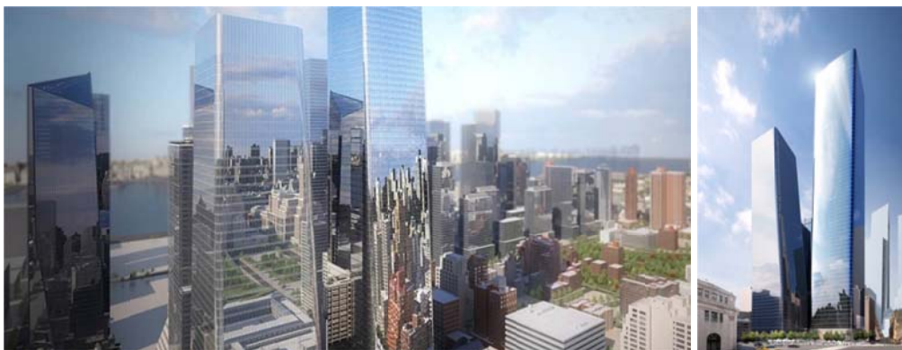
Слика 5.45. Стаклени омотач кула близнакиња ( West Towers ) на Менхентну пројектног бироа SOM (Skidmore, Owings & Merrill LLP) , чија тродимензионална форма је оптимизирана помоћу панела у форми трапезоидних цилиндара; (Извор: http://www.som.com/projects/manhattan_west_development )
