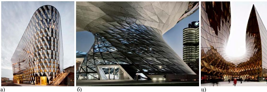
а) Слика 1.43. Различита панелизација стакленог омотача: а) Троугаона мрежа, објекат аудиторијума института Каролинска, Стокхолм, Шведска; б) Троугаона мрежа, објекат дистрибуционог центра BMW Welt , Минхен; и ц) Четвороугаона мрежа, објекат шопинг центра Емпорија, Малмо, Шведска (Извор: Преузето са: а) http://www.dezeen.com/2014/07/03/wingardhs-designs-an-auditorium-with-a-slanted-glass-facade/ , б) http://www.dezeen.com/2007/10/03/bmw-welt-by-coop-himmelblau-2/ и ц) http://www.dezeen.com/2013/09/27/emporia-shopping-centre-in-malmo-by-wingardhs/ , 12. 6. 2015)
