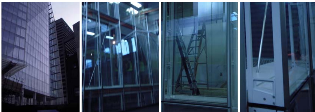
Слика П1.15. Изглед још недовршеног стакленог омотача и модел-узорак двоструке фасаде са стакленим панелима спратне висине, уским међупростором и отварањем унутрашњег ТИ панела ради одржавања, фабрика Scheldebouw, Middelburg , Холандија; (Извор: Аутор, 2012)
