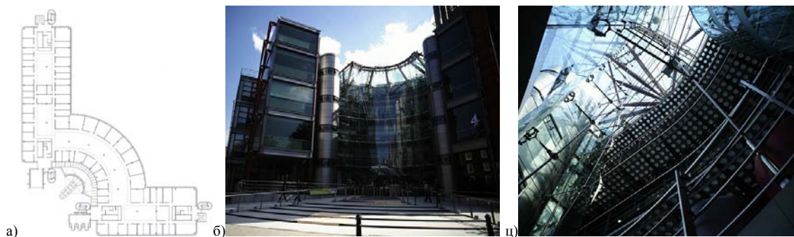
Слика П1.63. Основа спрата и изглед једноструко закривљене стаклене фасаде ТВ студија Channel 4 , (Извор: а) Schittich et al. 2007: 282; б) и ц) Преузето са: http://www.ajbuildingslibrary.co.uk/projects/display/id/445 , 27. 6. 2014)
