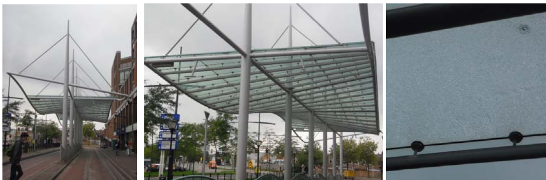
Слика П1.80. Изглед надстрешнице и стаклене површине са попречним цевастим ребрима (праве линије правоизводне површи) који носе челичне инокс држаче са спонама за фиксирање хладно савијених стаклених панела у жељену форму; (Извор: Аутор, 2015)
