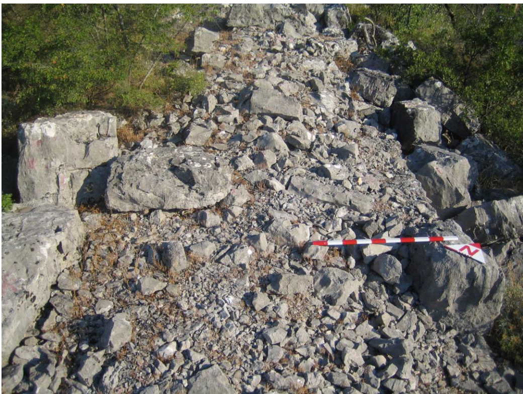
Слика 54: Бутеза – конструкција бедема (фотографисао М. Д.).
