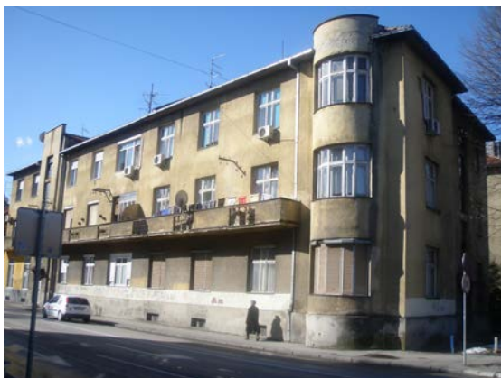
Слика 20. Стамбена зграда на углу Алеје Светог Саве и Улице Васе Пелагића (Центар)
