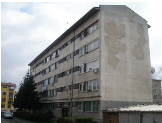
Слика 24. Стамбена зграда у Улици талијанског батаљона (Чаире-Кочићев вијенац)
