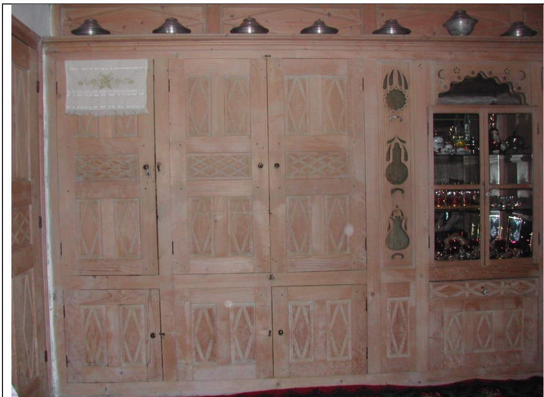
Slika 4 – Nastavak drvenog dograma (zdesna nalevo): džamluk, terežje, dušekluk i pomoćni dolap; vide se i pomoćni dolapi u okviru donjeg dela dograma među kojima je i podjkluk (ispod džamluka)
