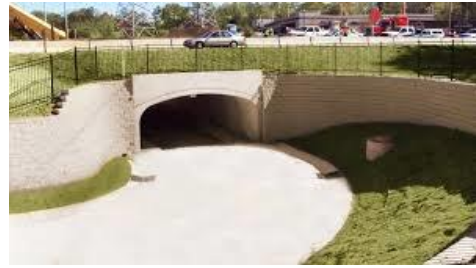
Слика 5.3 Подземни пролаз
