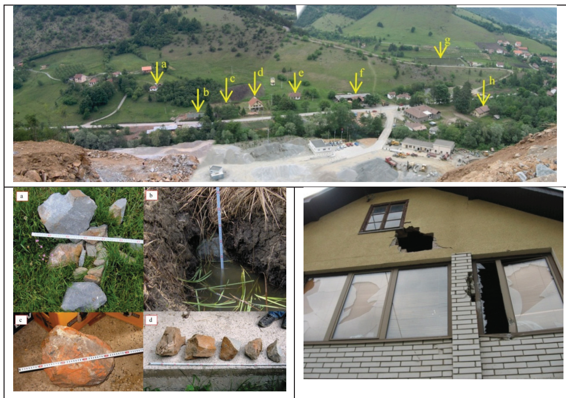
Slika 5.4 – Pogled na oštećene objekte sa etaže kamenoloma, razleteli komadi odminirane mase pronađeni na terenu i detalj oštećenja na objektu
