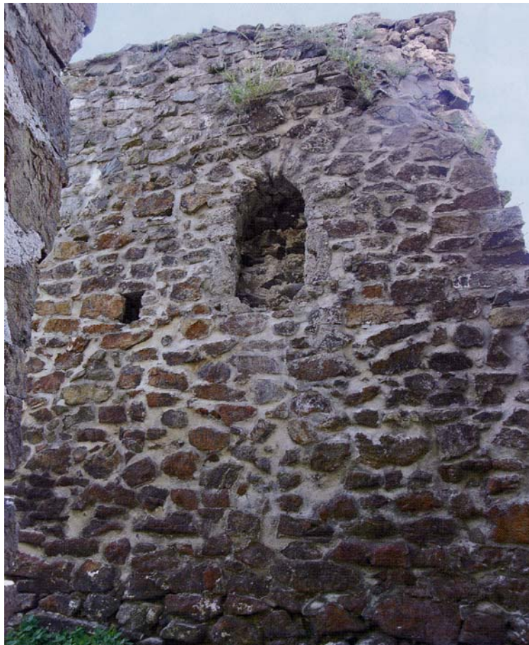
Сл. 85 – Црква Св. Ђорђа, јужни зид наоса и нартекса (горе) и део јужне фасаде са зазиданим прозором (доле), (М. Поповић, Маглички замак, стр. 100 и 101.)
