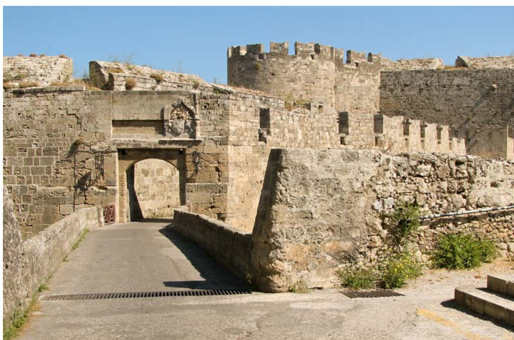
Сл. 122 – Тврђава Родос, изглед улазне капије са мостом, ( https://www.google.rs/search?q=tvrdjava+rodos&tbm=isch&tbo=u&source=univ&sa=X&ei )
