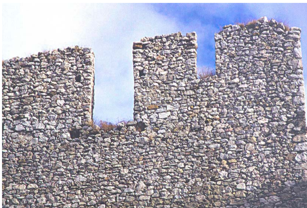
Сл. 14 – Трагови дрвене конструкције одбрамбеног балкона (машикуле) у кули 4, (Г. Симић, Средњовековни град Голубац, стр. 24.)
