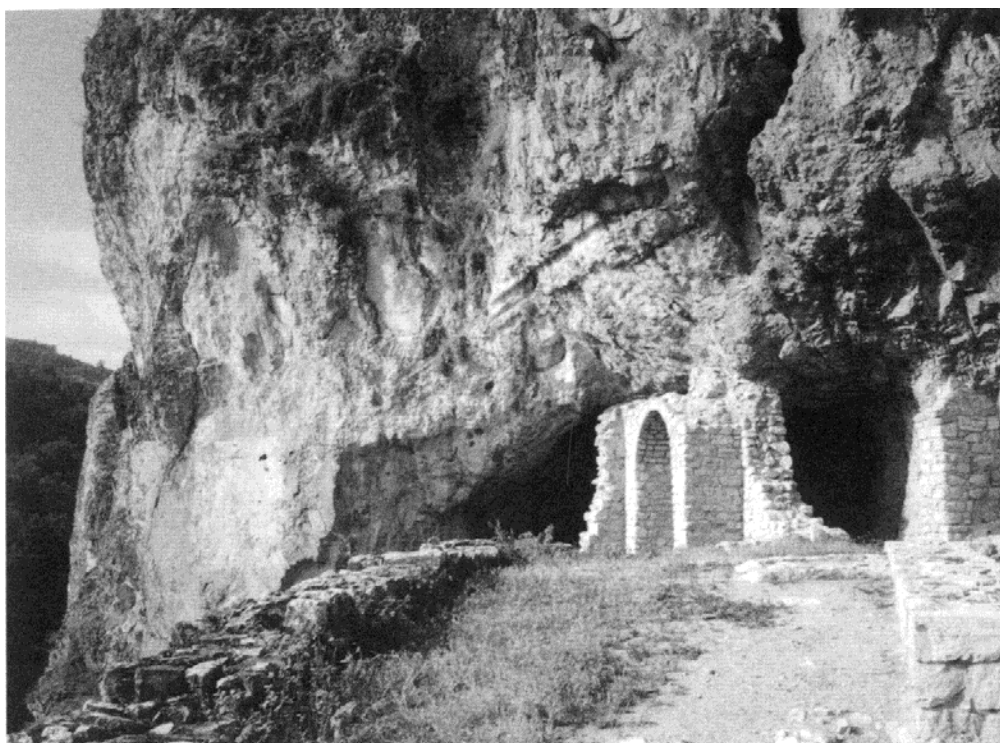
Сл. 56 – Манастир арханђела Михаила, пресек кроз малу пећину са северном фасадом цркве (горе) и остаци цркве после конзерваторских радова (доле), (М. Поповић, Тврђава Рас, стр. 281 и 282.)
