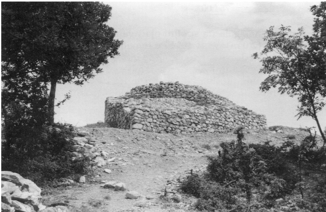
Сл. 41 – Призидано ојачање са јужне стране код главне донжон куле после конзерваторских радова, (М. Поповић, Тврђава Рас, стр. 177.)
