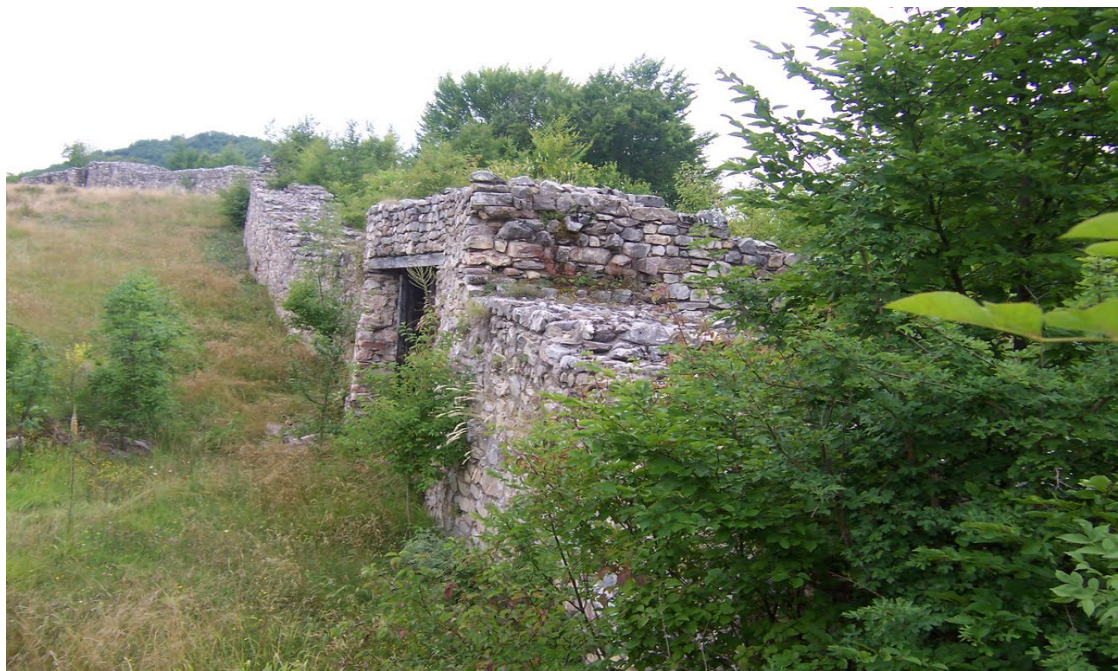
Сл. 47 - Поглед на остатке западног бедема и капију после конзерваторских радова, ( https://www.google.rs/search?q=stari+ras&tbm=isch&tbo=u&source=univ&sa=X&ei )
