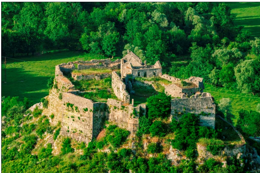
Сл. 152 – Тврђава Жабљак Црнојевића (Црна Гора), поглед на утврђење, ( https://www.google.rs/search?q=zabljak+crnojevica&biw=1517&bih=741&tbm=isch&tbo=u&source=univ&sa )
