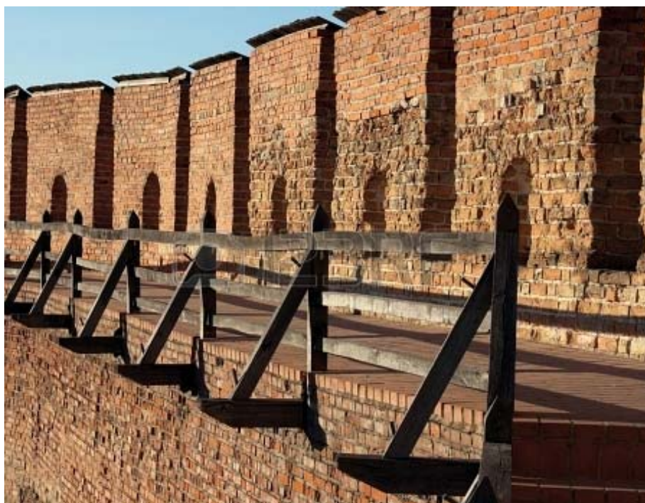
Сл. 134 - Тврђава Луцк, изгледи бедема након обнове са шетним стазама и зубцима, ( https://www.google.rs/search?q=tvrdjava+lutsk&tbm=isch&tbo=u&source=univ&sa=X&ei )
