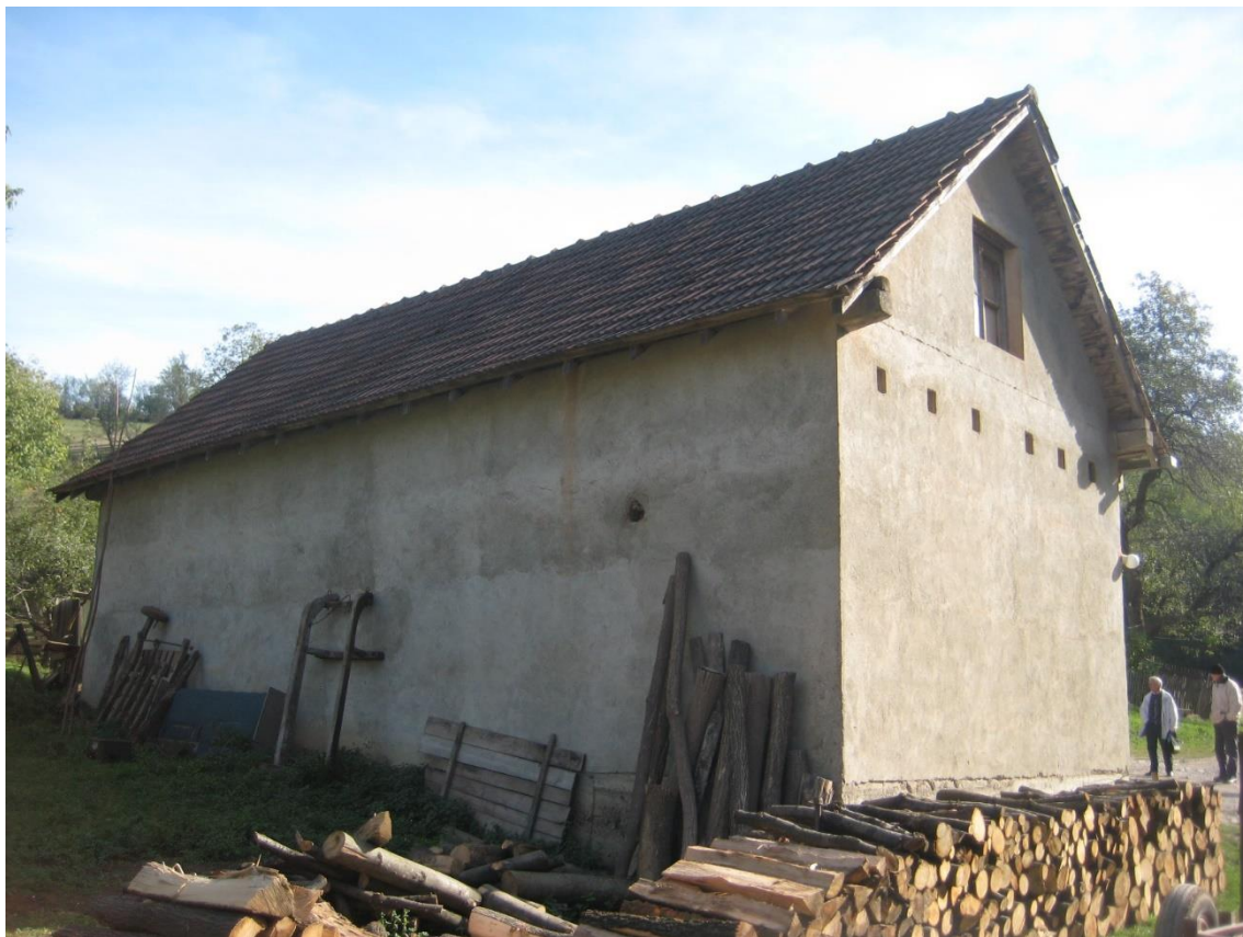
Слика 62: Изглед помоћног објекта (број 3) на мерном месту 3
