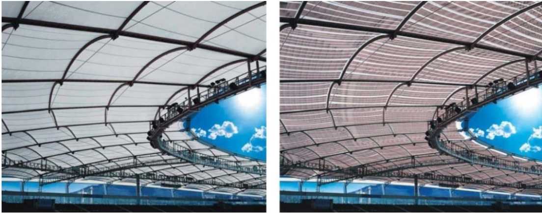
Слика 7 – покретни мембрански кров Готлиб-Даимлер Стадиона (Gottlieb-Daimler Stadion) у Штутгарту пре и после ламинирања Флексцелом (извор:[14])
