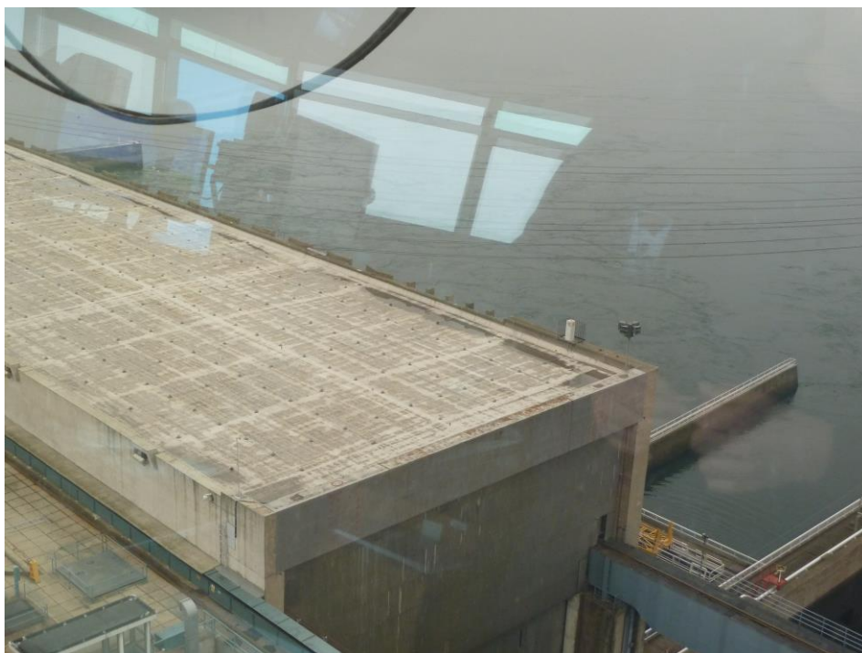
Slika 10.2: Fotografija prihvatnog sistema mašinske zgrade HE "Đerdap 1"
