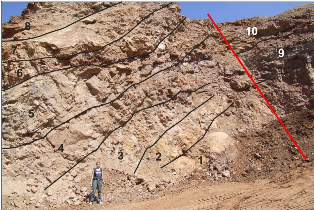
Slika 7.31. Otvorena etaža kamenoloma „Drenovac“ visine oko 10 m. 1-8 – paketi krečnjaka izdvojeni prema debljini slojeva. Crvena linija – rased. 9 – paket grudvastih krečnjaka „uvaljanih“ u sivi laporac. 10 – karstifikovani krečnjaci u površinskoj zoni.
