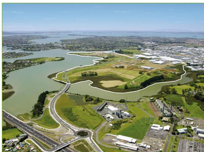
Слика 53. Првобитно стање локације Highbrook – бизнис парка на Новом Зеланду
