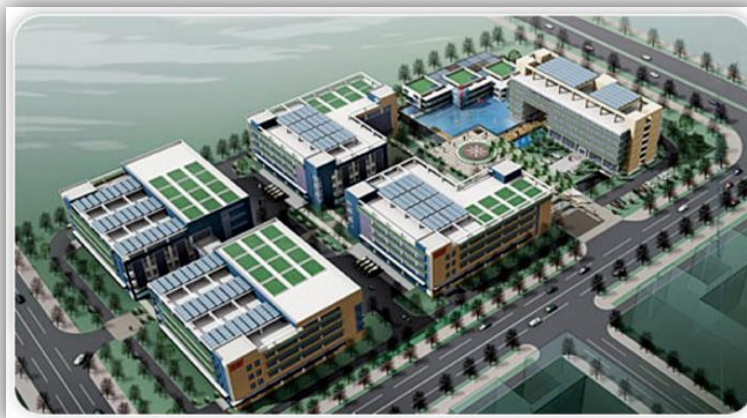
Слика 72. Индустијски парк- Shenzhen TRONY Industrial Park Photovoltaic Engineering, Кина
