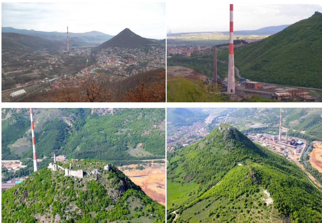
Слика 33. Изглед ППК „Трепча“ у простору забележено 2013/2015.
