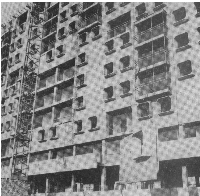
Сл.74. Блок 28 у изградњи.
