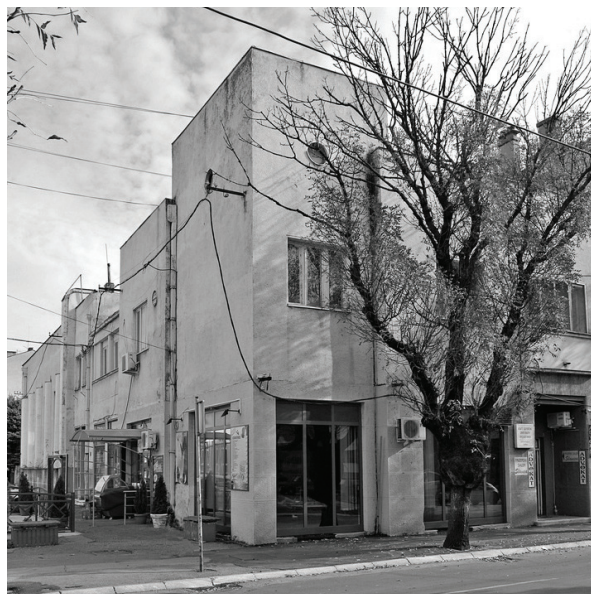
Сл.166. Занатски дом, Ћуприја.
