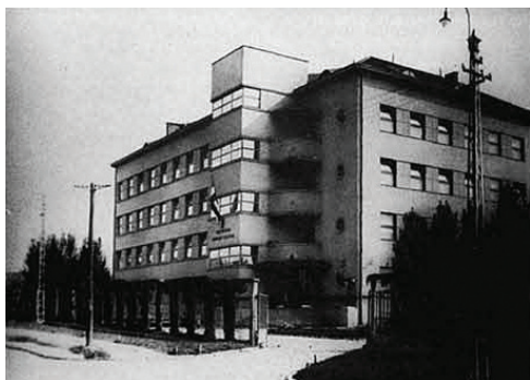
Сл.73. Општинска болница, Београд.
