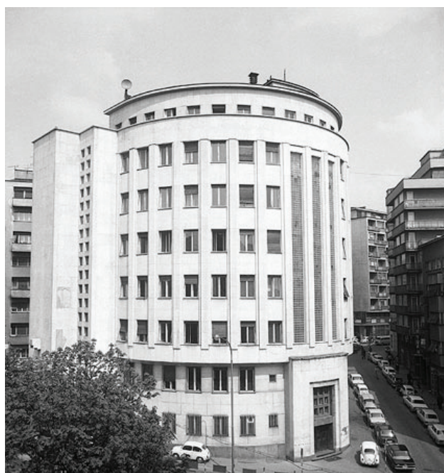
Сл.196. Палата Призад, Београд. Извор илустрације: http://beogradskonasledje.rs/kd/zavod/stari_grad/zgrada_prizad-a.html
