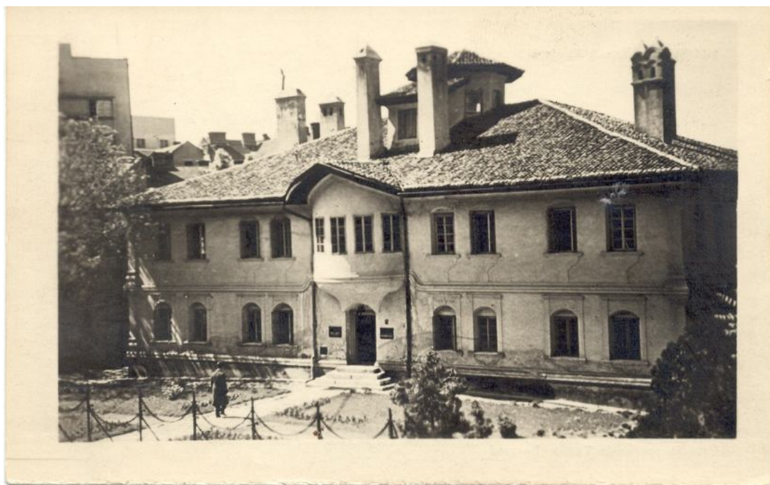
Сл. 23 Конак кнегиње Љубице у Београду, чеона фасада, снимак из фото документације Историјског музеја Србије бр. 29/29
