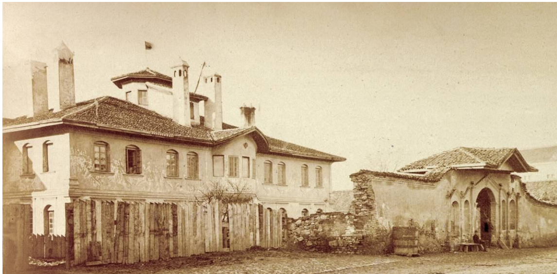
Сл. 22 Конак кнегиње Љубице у Београду, изглед према Богојављенској улици, снимак И. В. Громана из 1876. године, збирка Музеја града Београда инв. бр. ВМ Р 7655 (Ур 5053)
